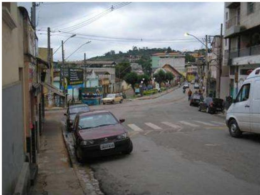
**Figura 19:** Estreitamento na Rua dos Passos – Não há um alinhamento preciso dos meio-fios ao longo da via, fazendo com ela mude de largura constantemente.
