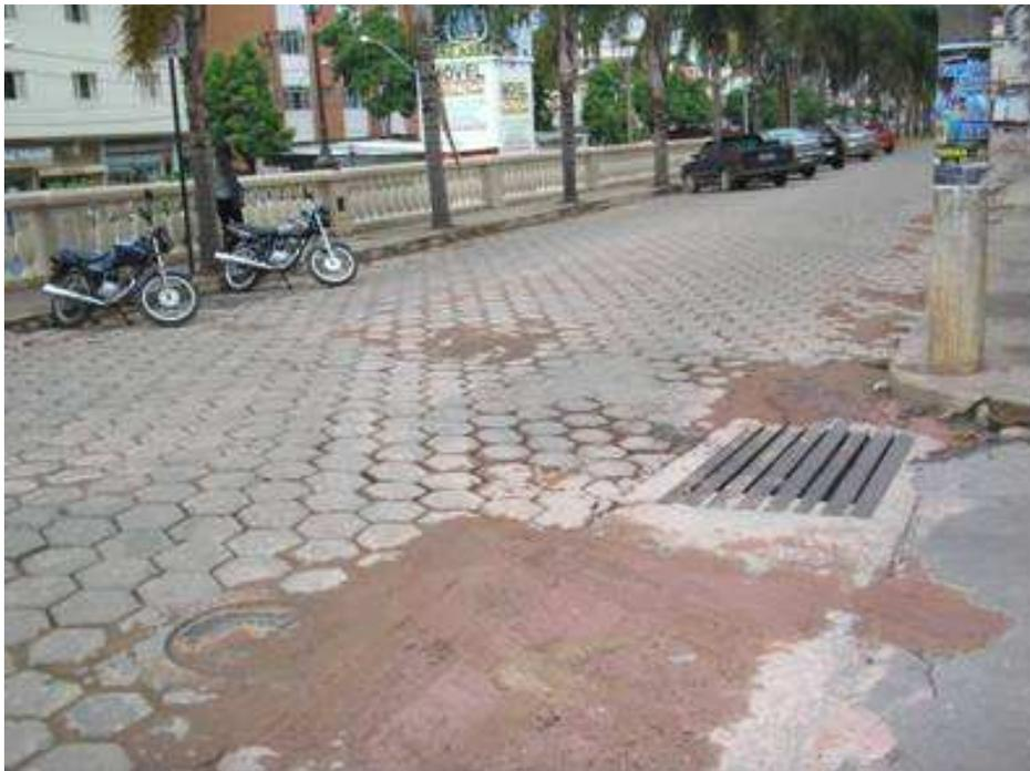
**Figura 50:** Pavimentação precária na Av. Bueno Brandão
