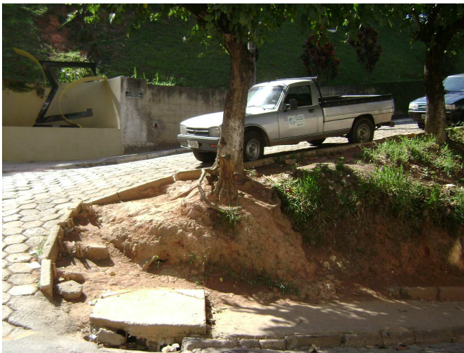
Foto 8: Conflito por gola com a pata-de-vaca na alameda Fábio R. Gomes. A árvore não possui gola nem espaço para suas raízes desenvolverem.
