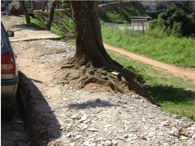
Foto 10: Outro conflito por gola na rua Álvaro Gouveia com uma flamboyant. Árvore imprópria para a calçada.
