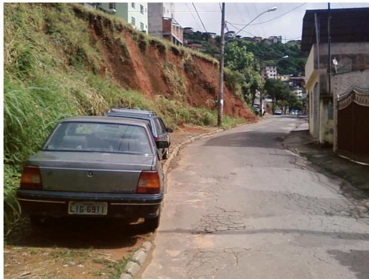
Foto 11. Rua Santana. Neste local também notamos a falta de acesso e visão para o córrego. Fonte: Acervo particular de Carolina Lemos Ferreira - 28/01/2012.
