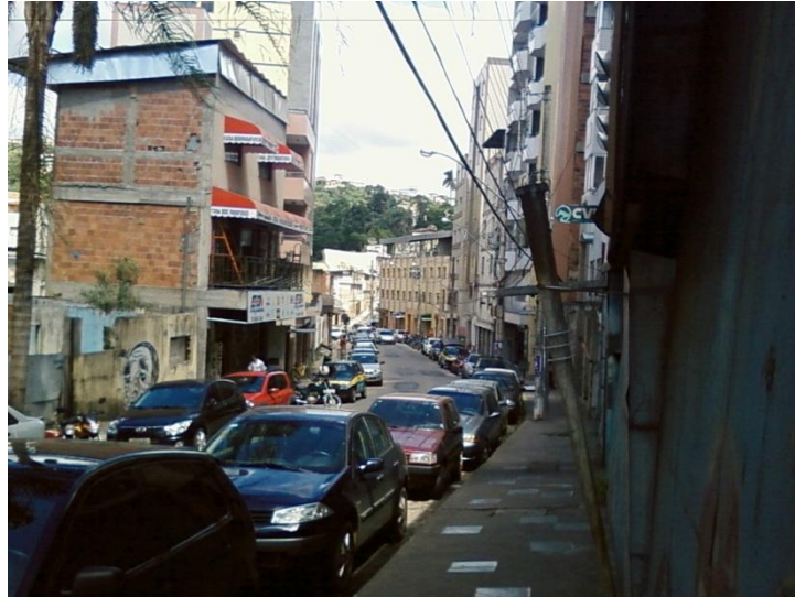
Foto 3: Rua Doutor Milton Bandeira. Os prédios e as casas dão as costas para o Ribeirão São Bartolomeu e são construídos de forma que não proporcionam nem acessibilidade nem visibilidade ao córrego. Fonte: Acervo particular de Carolina Lemos Ferreira - 25/01/2012.
