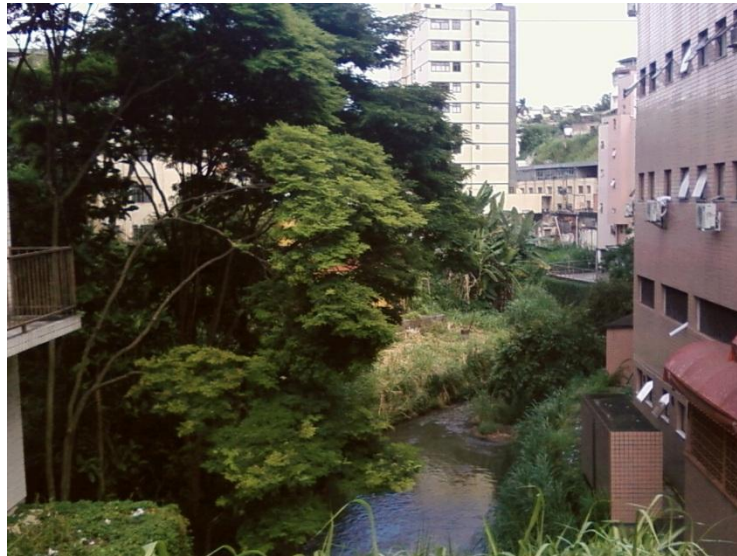
Foto 1: Vista da Travessa Presidente Tancredo Neves para o Ribeirão São Bartolomeu, evidenciando as formas de ocupação indevidas nas margens do mesmo, em que casas e prédios são construídos sem o afastamento ideal da calha do córrego, assim como a partir da retirada da vegetação das margens. Fonte: Acervo particular de Carolina Lemos Ferreira - 25/01/2012.
