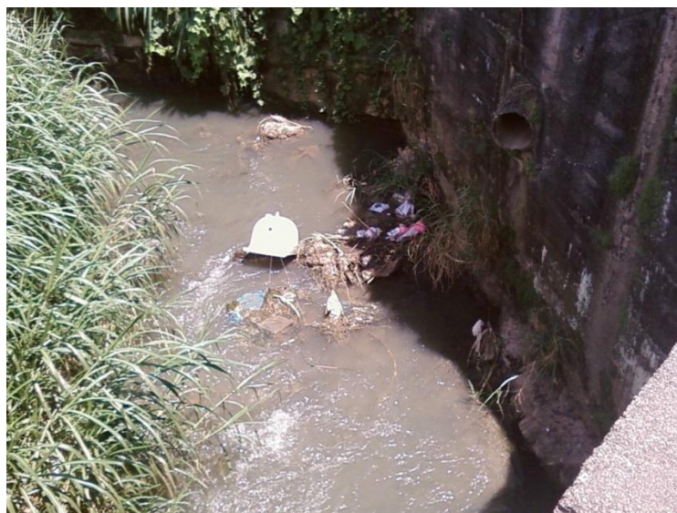
Foto 10. Travessa Santana. Lixo e esgoto lançados na calha do rio. Fonte: Acervo particular de Carolina Lemos Ferreira - 25/01/2012.
