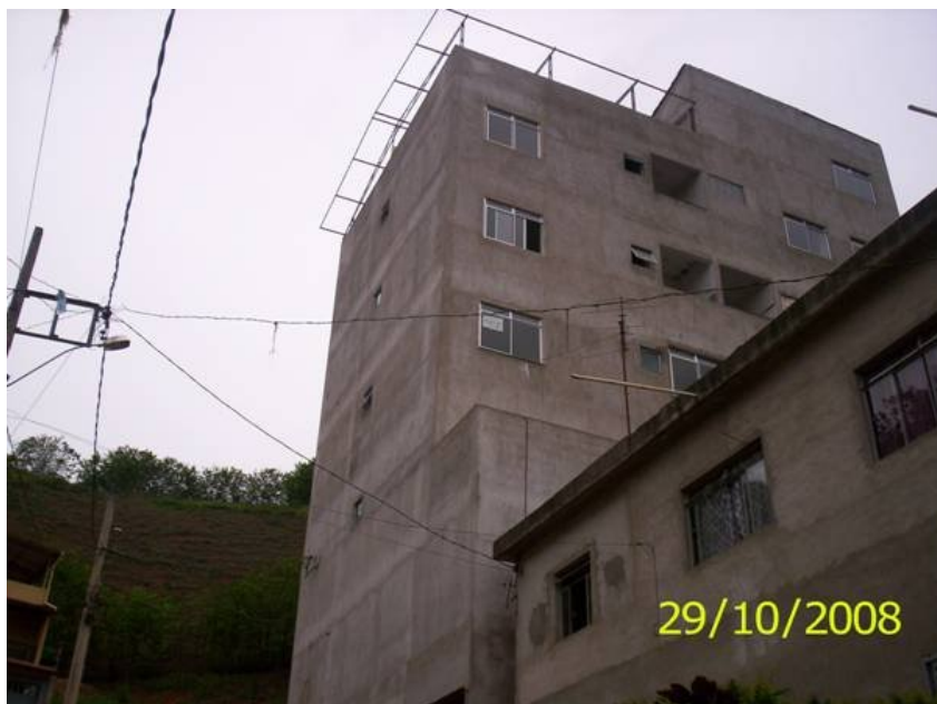
Figura 4 – Construção de edifício próximo à UNIVIÇOSA
