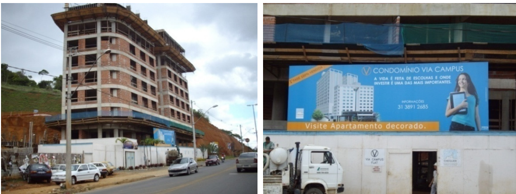
Figura 31 e 32: Foto: 24 e 25: Condomínio em construção da Chequer Negócios Imobiliários, na Av. Mal. Castelo Branco, no bairro Santo Antônio, em Viçosa (MG). Foto: Fabiano Ferreira Machado, set. 2009.
