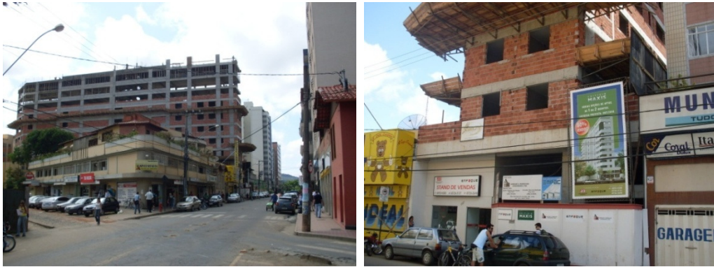
Figura 29 e 30: Foto 22 e 23: Condomínio em construção da Andrade e Rodrigues Engenharia, na Avenida P. H. Rolfs, com previsão para entrega em outubro de 2010. Foto: Fabiano Ferreira Machado, set. 2009.
