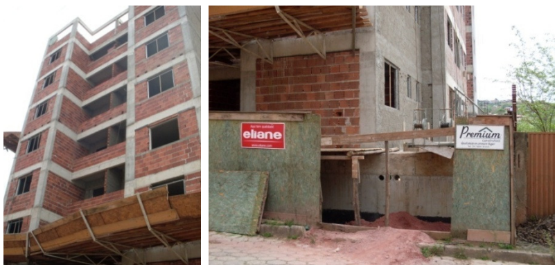
Figura 33 e 34: Foto: 26 e 27: Condomínio sendo edificado da Premium Construção, rua Raimundo Alves Torres, no bairro de Ramos, Viçosa (MG). Foto: Fabiano Ferreira Machado, set. 2009.
