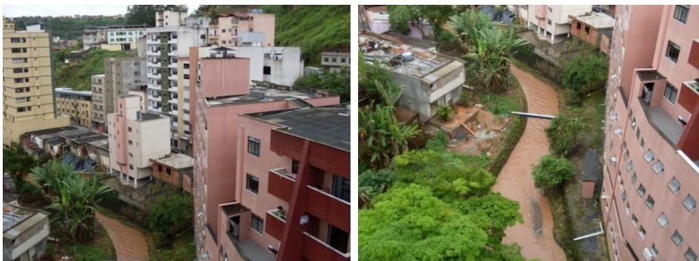
Figura 42 e 43: Foto: 31 e 32: Edificações próximas ao ribeirão São Bartolomeu em Viçosa (MG), em desrespeito as leis federais de do Código Florestal e 6.766/79. Foto: Fabiano Ferreira Machado, out. 2009.
