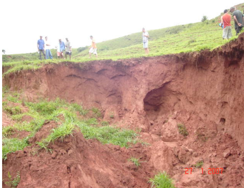
Figura 2. Aspecto de uma voçoroca no assentamento.
