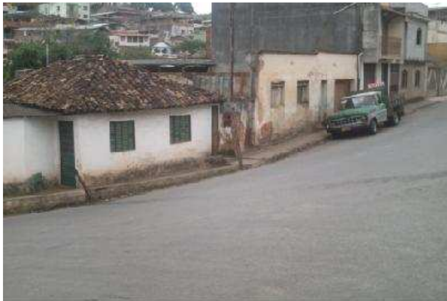
Figura4: Casas construídas sobre uma nascente, segundo afirmações de moradores, entroncamento das Ruas da Conceição e das Estrelas, Viçosa-MG, 2009. Registro do autor: 05/09/2009.
