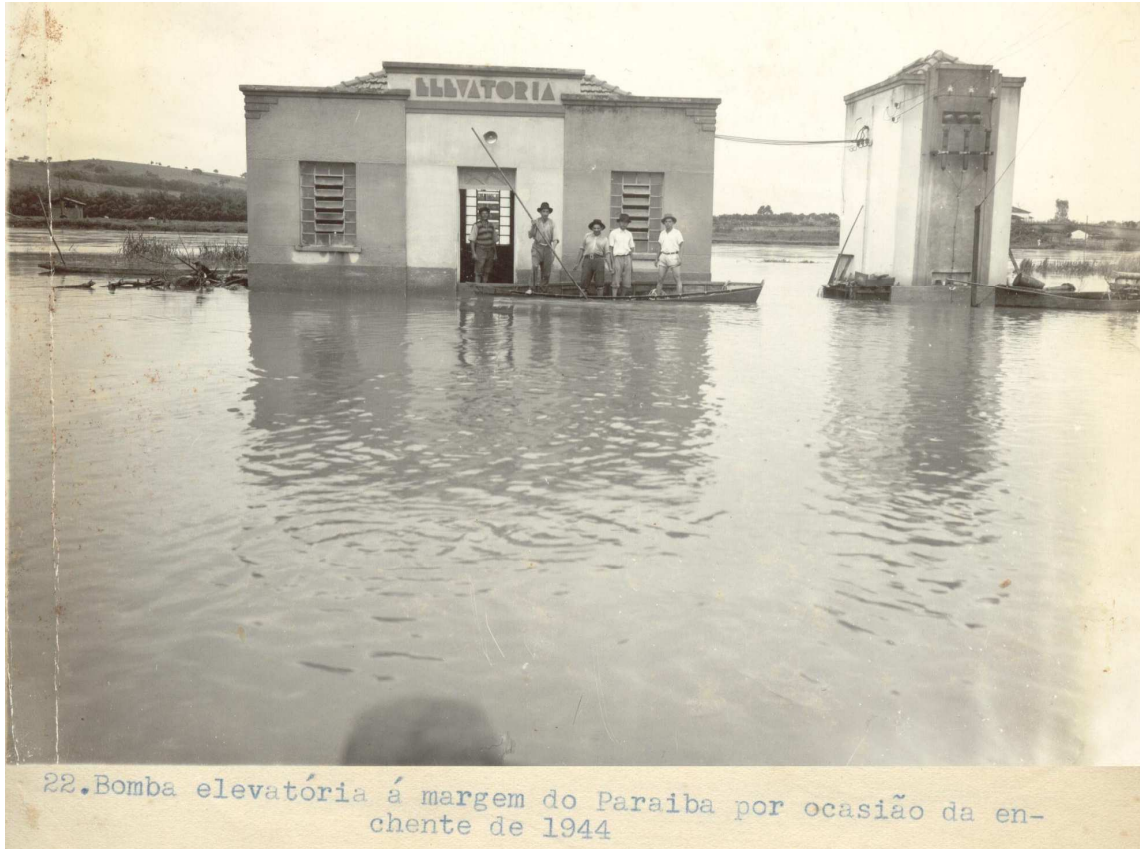
Figura 20: Foto da bomba elevatória do Rio Paraíba do Sul inundado em 1944, devido a forte chuva. Arquivo Público histórico de Jacareí 2012.
