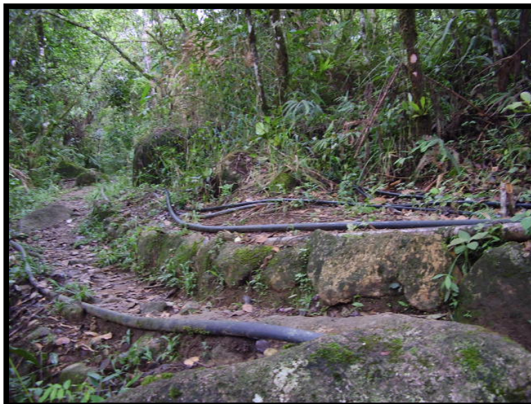
Foto 13a - Canos de captação de água
