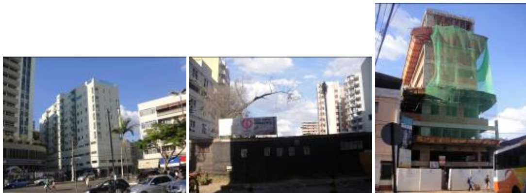
Figuras 31, 32 e 33 – Edificações verticais sendo construídas nas proximidades da Praça Silviano Brandão, Rua Presidente Tancredo Neves e Praça do Rosário, respectivamente. Fonte: Arquivo pessoal – maio 2011.
