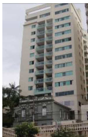
Figura 48 – Parte da residência histórica preservada. Fonte: Arquivo pessoal (maio 2011)
