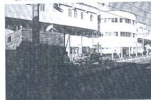
Até o Hospital São Sebastião está construindo "um puxadinho" fora do alinhamento com seus demais prédios e sem obedecer o afastamento de lei
