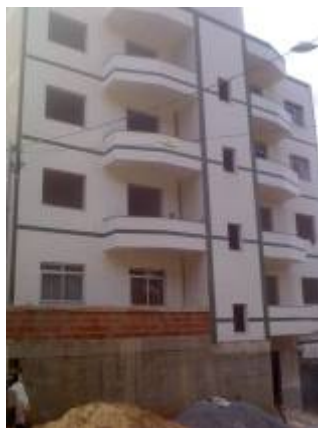
Figura 38 – Apartamento ainda em fase de construção em João Braz, na Rua São Geraldo.
