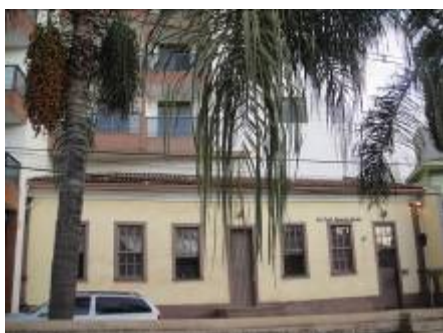
Figura 47 – Fachada tombada do antigo hospital da cidade. Fonte: arquivo pessoal (maio 2011)
