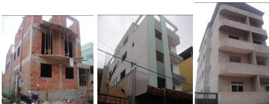
Figura 40 – Prédios ainda em fase de construção em João Braz, na Rua Tiradentes.
