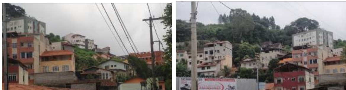
Figura 19 – Vista parcial do bairro João Braz, atrás da Cabana Roda.
