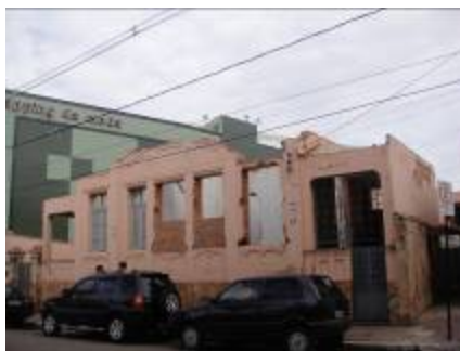
Figura 46 – Edificação antiga sendo destruída na Praça do Rosário. Fonte: Arquivo pessoal (maio 2011).
