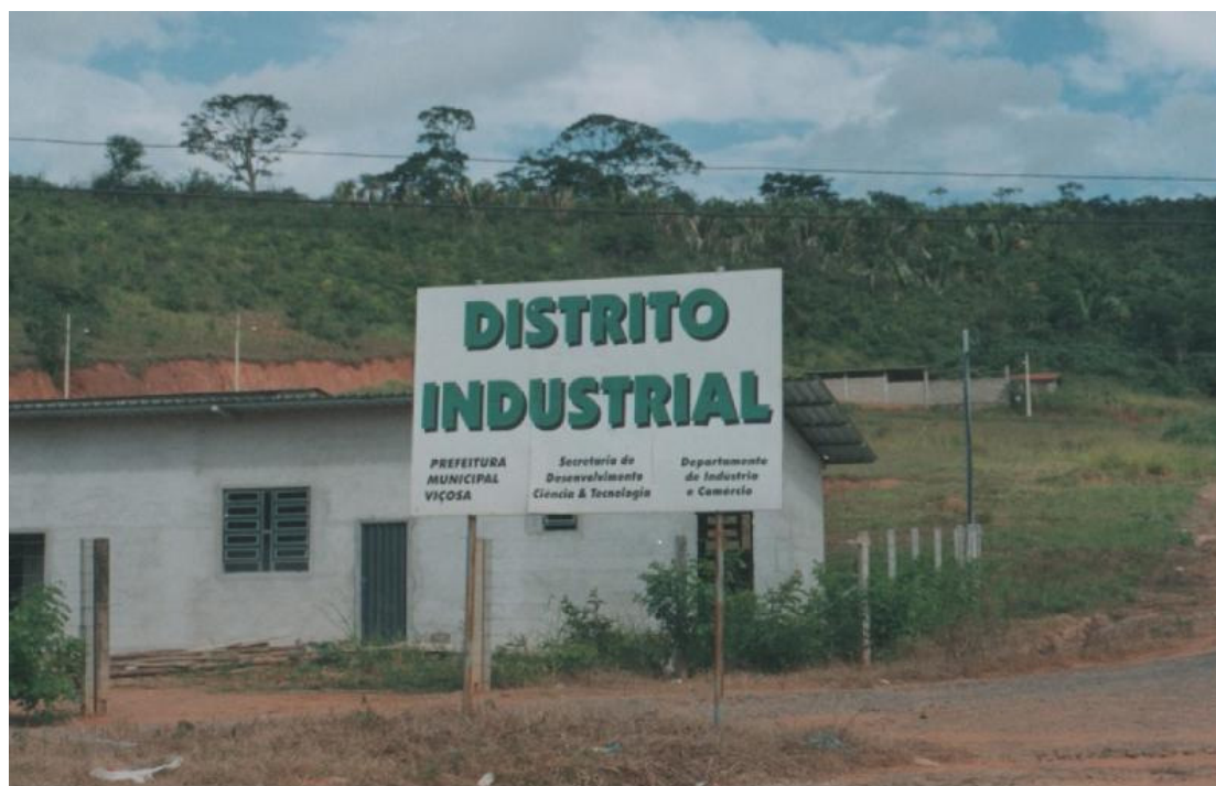
Figura 07 - Foto – Distrito Industrial da Barrinha em Viçosa – MG.
