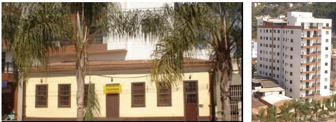
Figura 04 - Foto – Formas híbridas na região Central de Viçosa – MG. Destaque para a fachada principal Autor: Leandro Dias Cardoso Carvalho, 2007.
