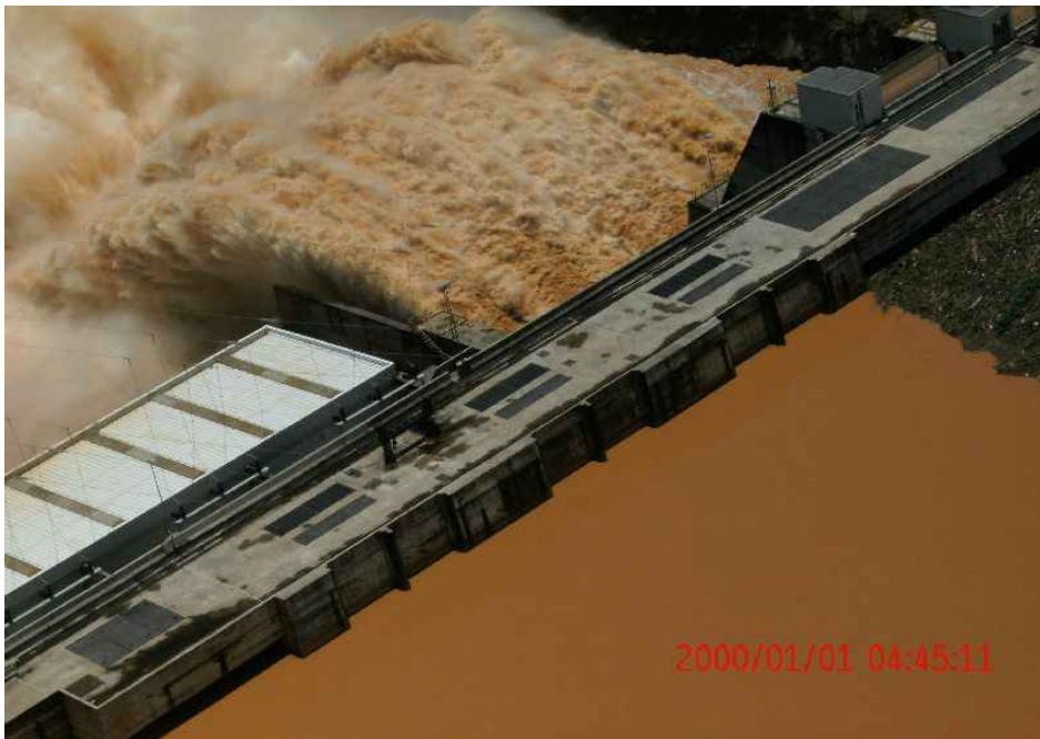
Figura 4: Usina Hidrelétrica de Candonga em 18/12/2008.
