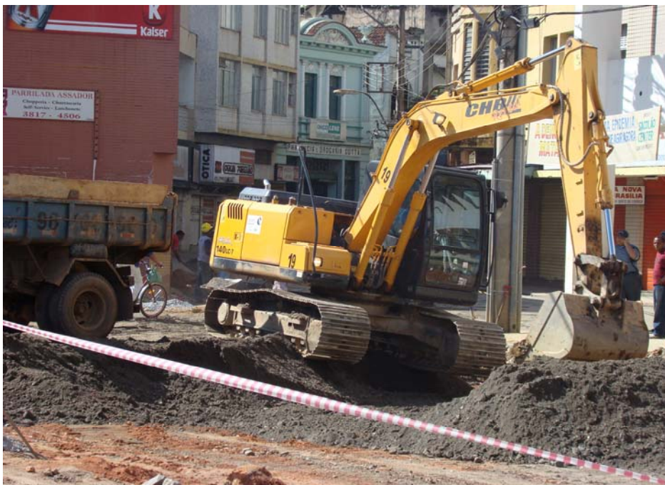
Figura 6: Trator em obra de recuperação da Avenida Arthur Bernardes em 18/04/2009. Fonte: Foto de Leonardo Alves de Oliveira Silva.
