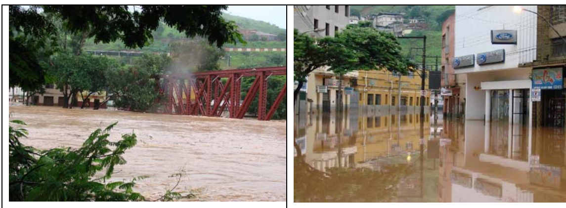
Figura 27: À esquerda o Pontilhão de ferro parcialmente encoberto pelas águas. À direita a Avenida Abdala Felício no Centro Histórico, completamente inundada.
