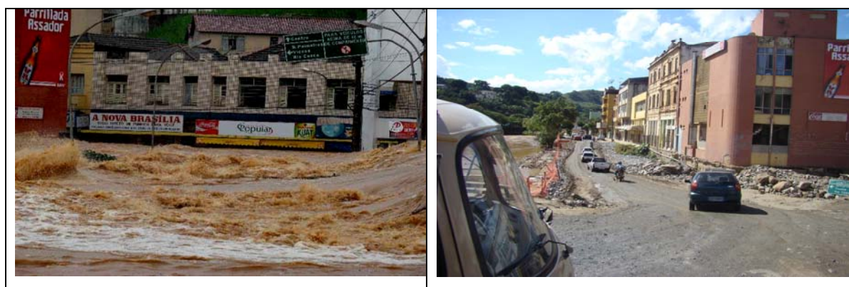
Figura 26: À esquerda a Avenida Arthur Bernardes inundada. À direita a mesma avenida danificada e em obras de recuperação.
