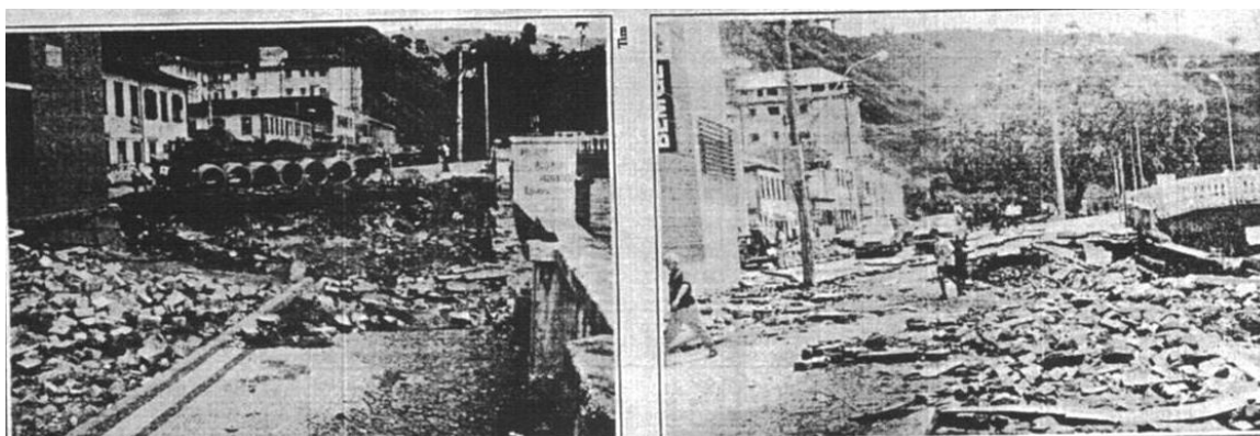
Figura 18: À esquerda a Avenida Arthur Bernardes depois da enchente de 1979. À direita a mesma avenida depois da enchente de 1997. Fonte: Jornal Folha de Ponte Nova.
