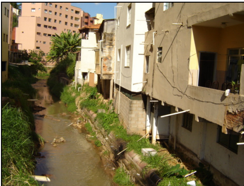
Figura 4: Foto de construções residenciais às margens do Ribeirão São Bartolomeu, sem respeitar o limite de 30 metros de distância exigido por lei. Registro feito pelo autor. Data: 12/04/2006
