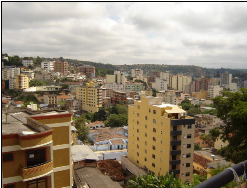
Figura 5: Foto panorâmica mostrando o elevado número de prédios na cidade de Viçosa. Registro feito pelo autor. Data: 12/04/2006
