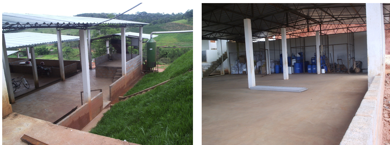
Figura 6: Instalações da Usina de Triagem e Compostagem
