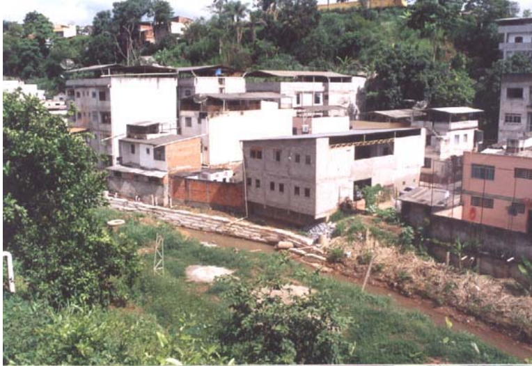
Figura 21. Ocupação da margem do Ribeirão São Bartolomeu.
