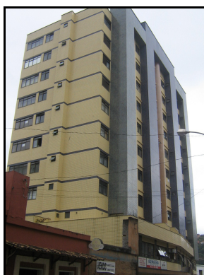
Figura 02: Edifício Flat Center, localizado na Rua Dr. Milton Bandeira. Foto: Elaine Santiago Ferreira, maio 2008.
