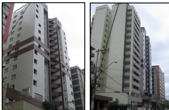
Figuras 03 e 04: Edifícios Tocqueville e Viçosa Park Residence, localizados na av. P.H. Rolfs. Fotos: Elaine Santiago Ferreira, maio 2008.
