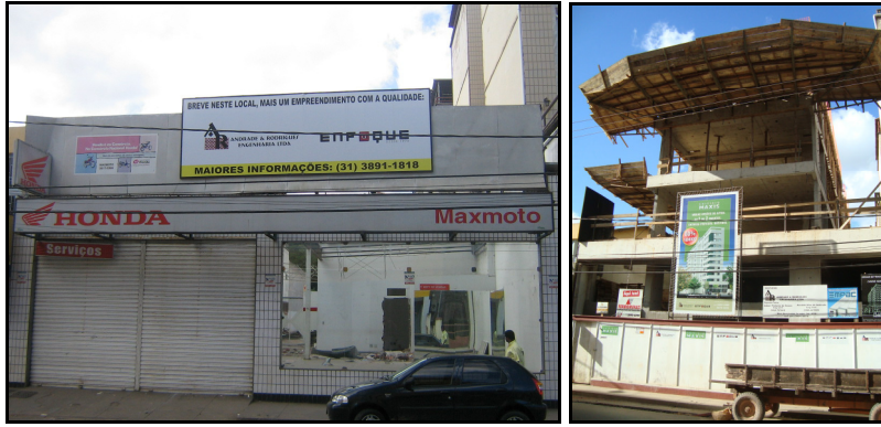
Figuras 25 e 26: Terreno anteriormente ocupado por uma loja, localizado na Av. P.H. Rolfs, área muito valorizada pelo mercado imobiliário da cidade, onde está sendo construído mais uma edificação vertical (2007 e 2009). Fotos: Raquel Callegario Zacchi, abril de 2007 e maio de 2009.
