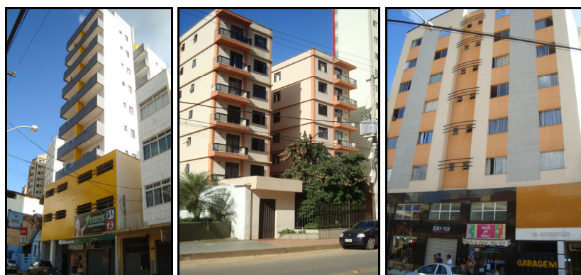
Figuras 10, 11 e 12: Alguns edifícios presentes na Av. P.H. Rolfs, Centro de Viçosa (MG). Fotos: Elaine Santiago Ferreira, maio 2008.
