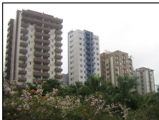
Figura 13: Edifícios localizados na Travessa Vereador Jose Valentino da Cruz Reis (Ladeira dos Operários). Foto: Elaine Santiago Ferreira, maio 2008.
