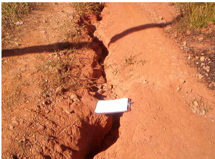
Figura 14 - Vista Parcial da Rua Carangola Autora: MARTINS, S. de S., 2006.
