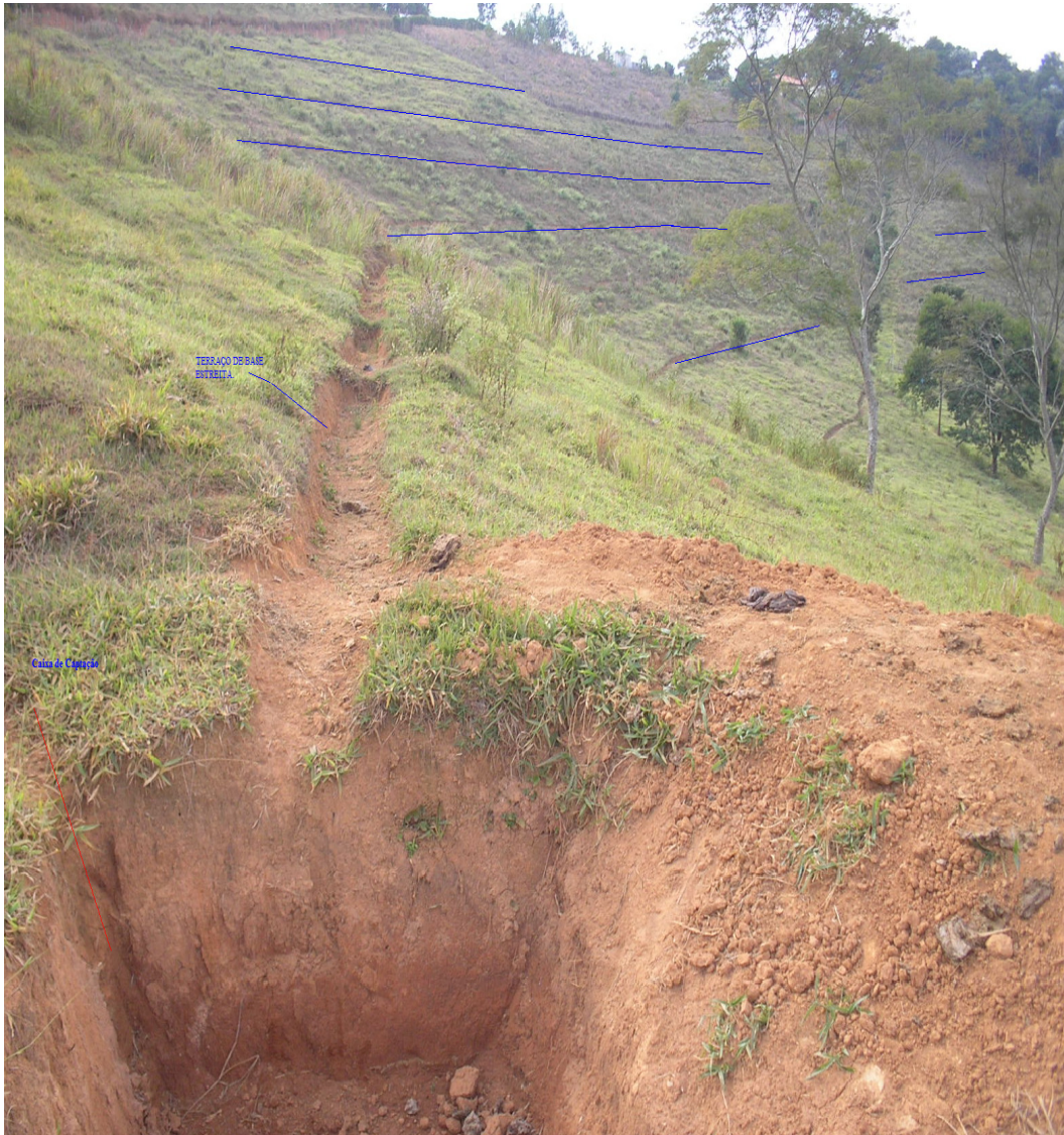
Figura 9. – Visualização dos terraços de base estreita e da caixa de captação, localizada na cabeceira do córrego do engenho, próximo do Sítio Vitarelli.
