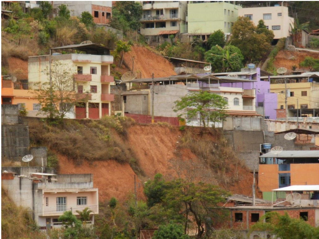
Foto 5 - Área de risco no bairro João Braz.
