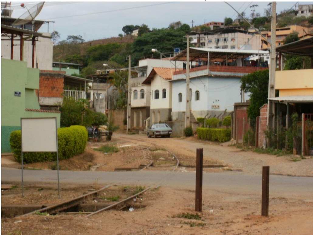
Foto 10 - Linha férrea em cruzamento com a Rua José Lustosa, distrito de Silvestre.
