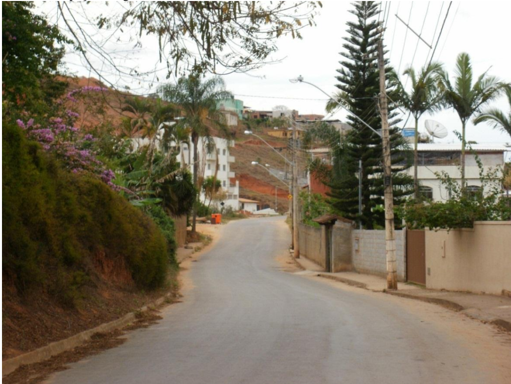
Foto 2 - Ocupação Irregular no CS no Distrito de Silvestre.
