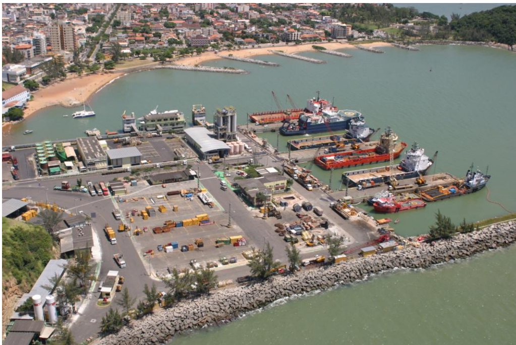
Figura 9 – Porto da Imbetiba/Petrobrás (atual)
