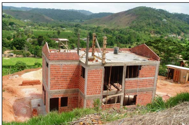
Fig. 19. Casa sendo construída do condomínio Sem Domínio. Nov.2007.
