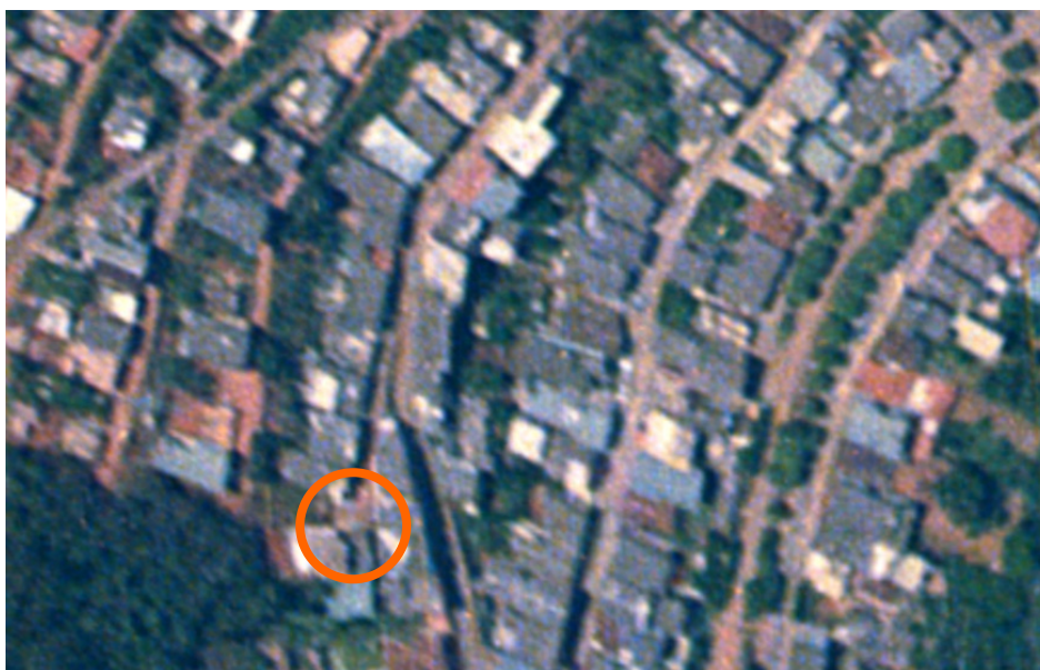
Figura 6. Figura de localização do talude do bairro São Sebastião. Fonte: Prefeitura Municipal de Viçosa; NEPUT (2006)
