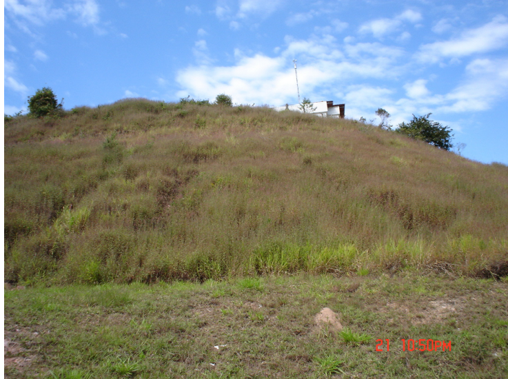
Figura 4. Talude experimental situado atrás do Departamento de Artes e Humanidades.
