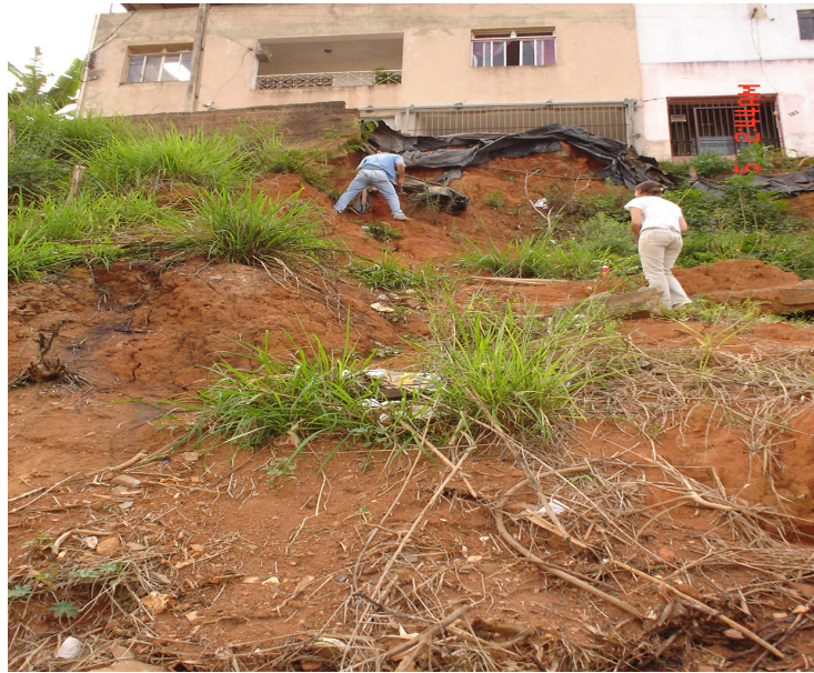
Figura 2. Talude experimental do Bairro São Sebastião. Fonte: Faria, A.L.L (2005)
