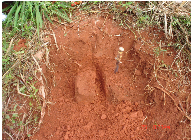
Figura 11. Coleta do torrão no talude do bairro São Sebastião.
