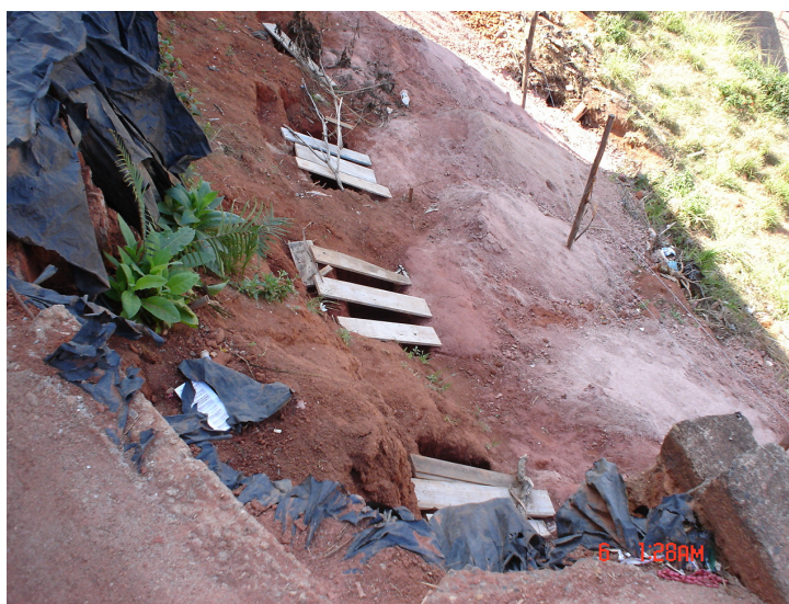
Figura 16. Isolamento do talude e início das obras para a contenção.
