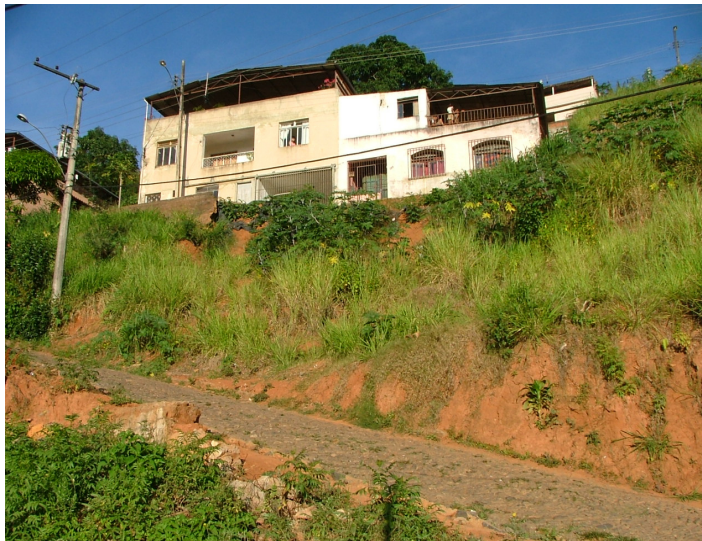
Figura 15. Restabelecimento inicial da vegetação no talude do Bairro São Sebastião.
