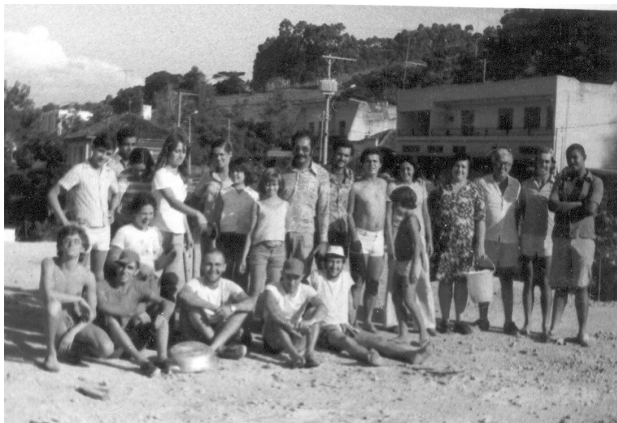
Figura 3.14: Multirão para construção do 2º templo, entres eles a família do Reverendo Elben César, estudantes da UFV e do Coluni-UFV, serventes contratados e outros membros da Igreja
