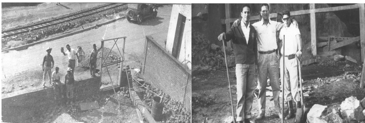
Figura 3.7 : Início da construção do primeiro templo
