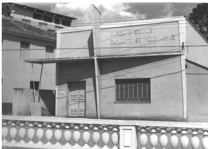
Figura 3.8: Término da construção do primeiro templo Fonte: Arquivo histórico da Igreja Presbiteriana de Viçosa (1960)
