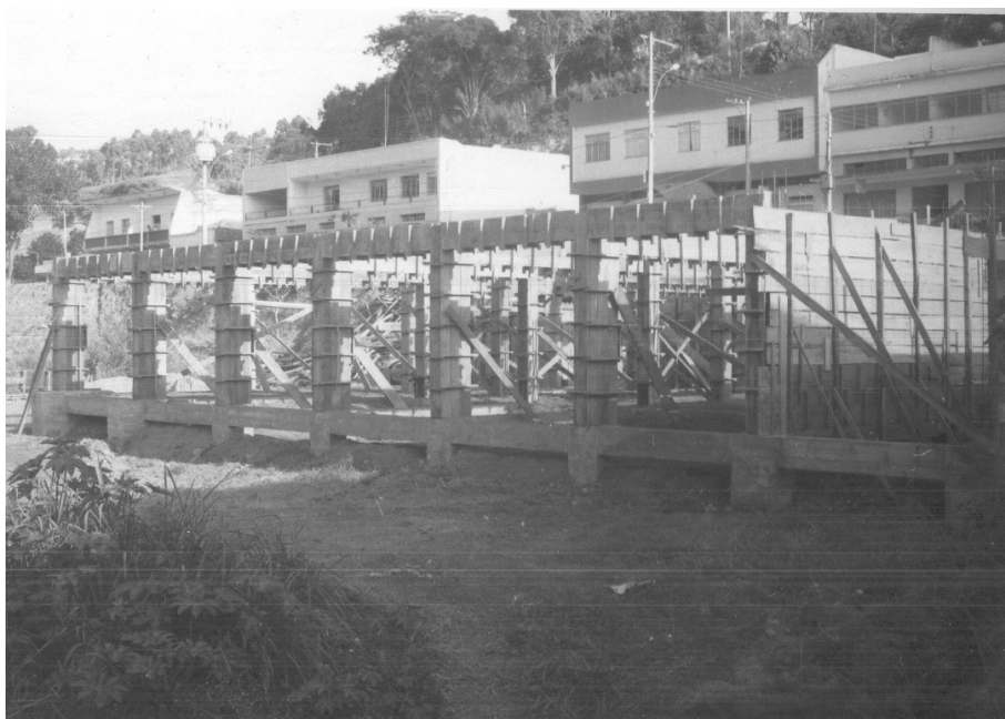
Figura C.1: Início das obras de construção do 2º templo Fonte: Arquivo histórico da Igreja Presbiteriana de Viçosa (1975)
