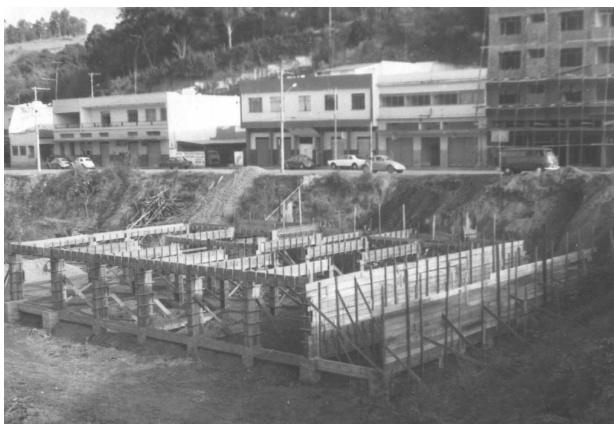
Figura C.2: Início das obras de construção do 2º templo Fonte: Arquivo histórico da Igreja Presbiteriana de Viçosa (1975)
