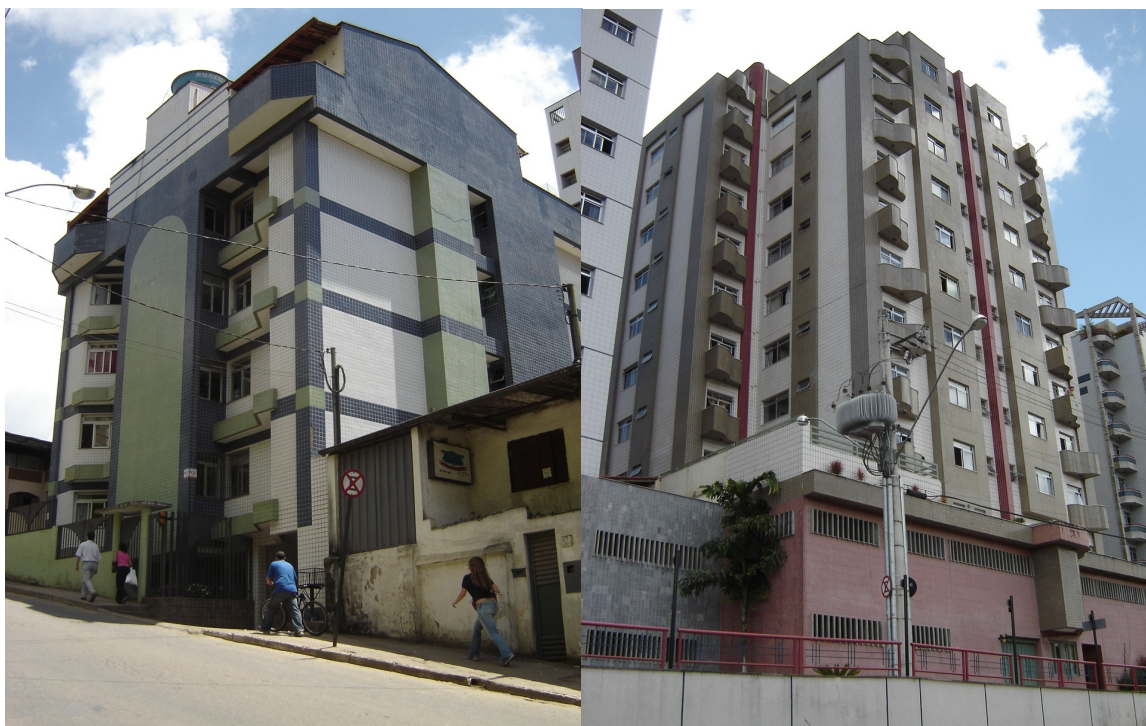
Figura C.20: Prédios sede de repúblicas formadas por participantes da comunidade da Igreja Presbiteriana de Viçosa, na Rua José Valetino da Cruz – centro Foto: Juliana Gonçalves Moreira (06 fev. 2007)
