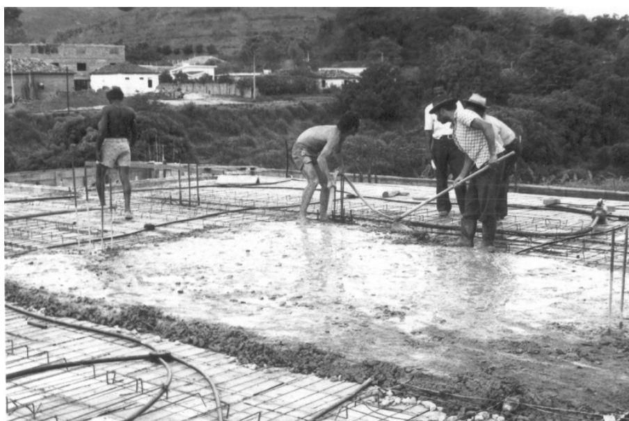
Figura C.6: Mão-de-obra trabalhando nas obras de construção do 2º templo Fonte: Arquivo histórico da Igreja Presbiteriana de Viçosa (1975)
