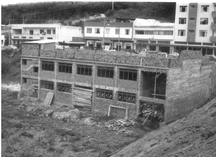
Figura C.5: Andamento das obras de construção do 2º templo Fonte: Arquivo histórico da Igreja Presbiteriana de Viçosa (1975)
