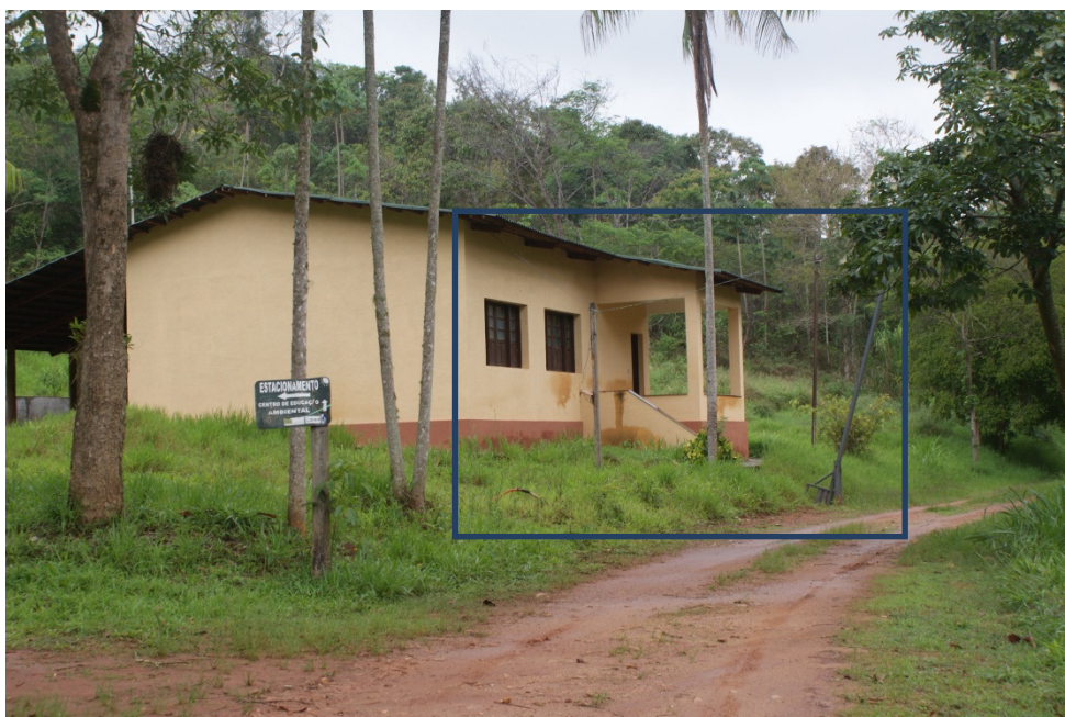
Figura 20 – Nova sede da EPTEA com destaque para a guarita com a cancela Foto: Ana Carolina F. Torres
