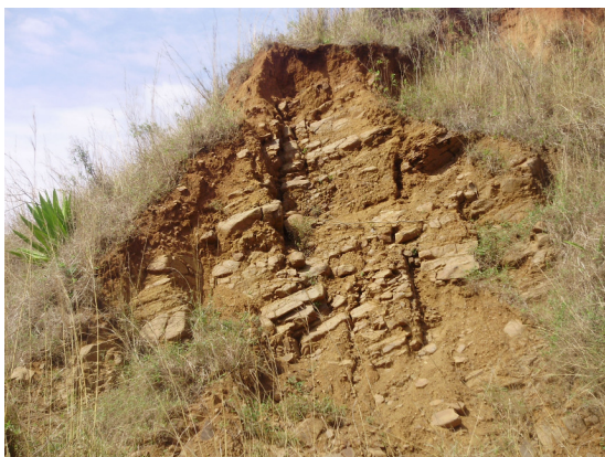
Foto 01 - Colapso de taludes em Neossolo Litólico.
