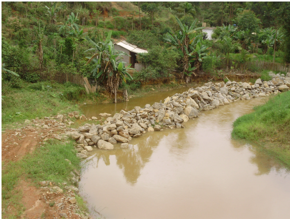
Foto 16 - Barragem para evitar o solapamento da margem próxima à casa.
