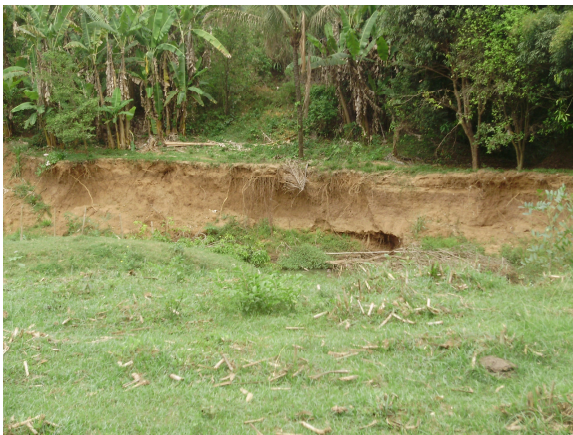
Foto 18 - Desbarrancamento das margens do rio Bagres.
