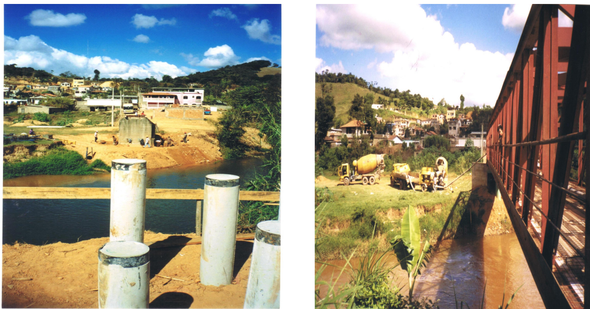
Figura 42: Construção da nova Ponte Secundária após a inundação de janeiro de 1997. Observa-se que no final da década de 1990, ainda não havia as construções nas proximidades da Ponte. Fotografia obtida por: Carlos Araújo Silva.
