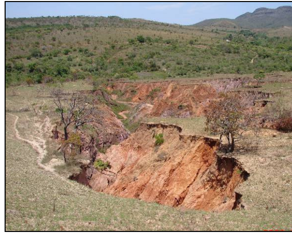
Foto 12: Vista da voçoroca à jusante.
