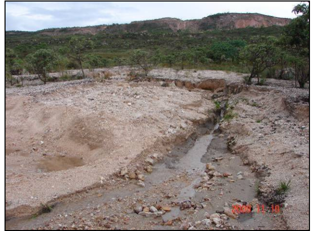
Foto 22: Foco erosivo, carreamento de sedimentos proveniente da mineração (quartzito) no alto da serra.
