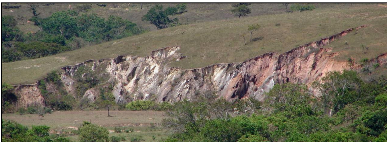
Foto 10: Voçoroca V01(CRG), localizada na margem direita do córrego Rio Grande.
