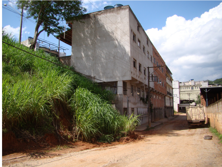
Figura 9: Construções nivelando com a avenida
