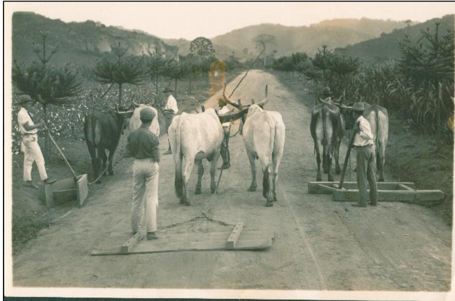
Figura 2: Obra de planificação da Av. da Agronomia ,década de 20.
