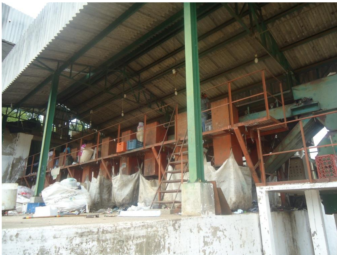
Figura 1: Vista parcial e bag's na Usina de Triagem e Reciclagem de Viçosa
