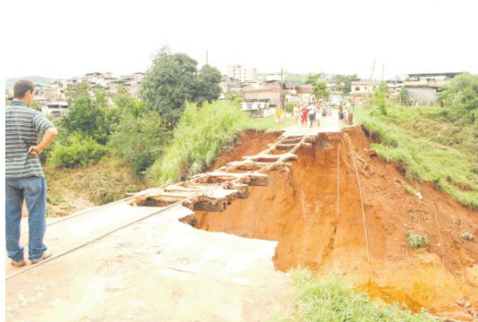
No Vale do Sol, a galeria sob a via férrea, por pressão do Córrego das Posses, rompeu-se, ficando suspensa no ar (foto acima, à esquerda), o mesmo acontecendo no trecho entre as Nove Cruzes, na entrada do bairro São José (foto acima, à direita)
