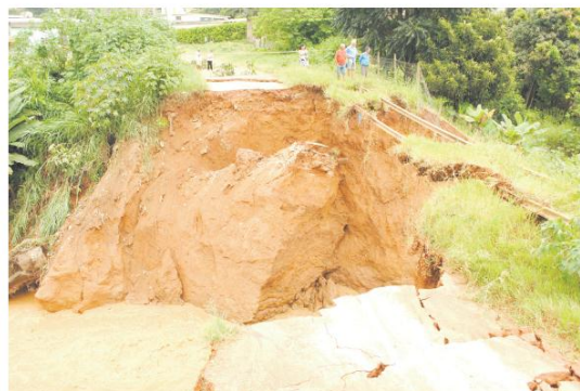
No Vale do Sol, a galeria sob a via férrea, por pressão do Córrego das Posses, rompeu-se, ficando suspensa no ar (foto acima, à esquerda), o mesmo acontecendo no trecho entre as Nove Cruzes, na entrada do bairro São José (foto acima, à direita)
