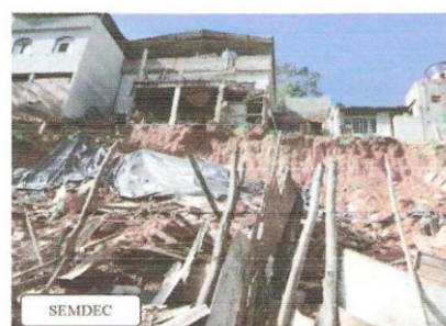
Figura 15 – Desabamento de casa – R: J. L de Castro
