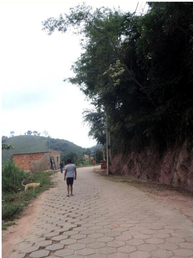
Figura 12 - Afundamento no leito da Rua Irmã Eulina e árvore inclinada na parte superior direita da foto.
