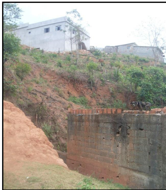
Figura 19: Construção abandonada localizada abaixo de área de encosta.
