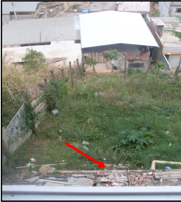
Figura 15: Entulho na encosta localizada atrás da Casa (figura 14).
