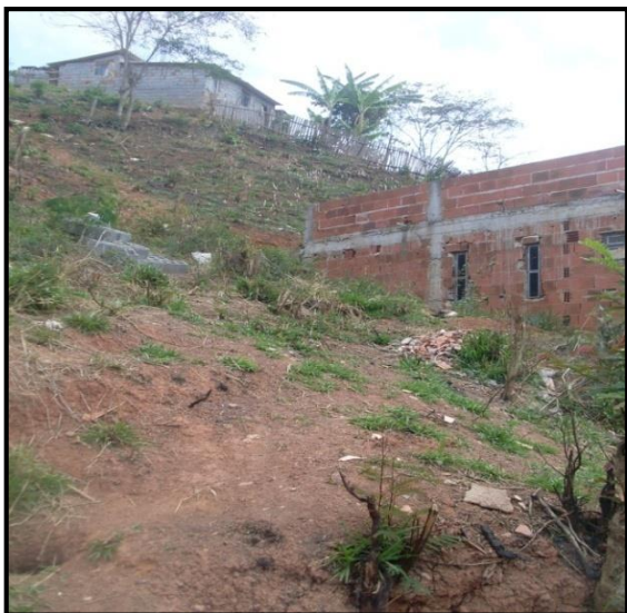
Figura 11: Moradias localizadas em áreas de risco.
