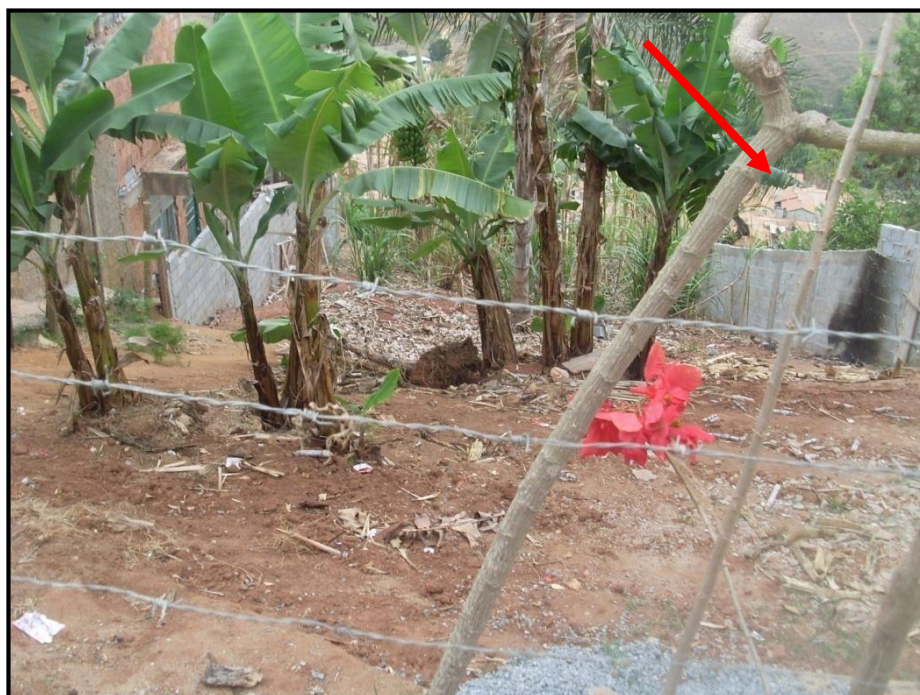
Figura 8: Casa situada em uma encosta com grau de inclinação elevado, logo abaixo estão localizadas as casas populares.
