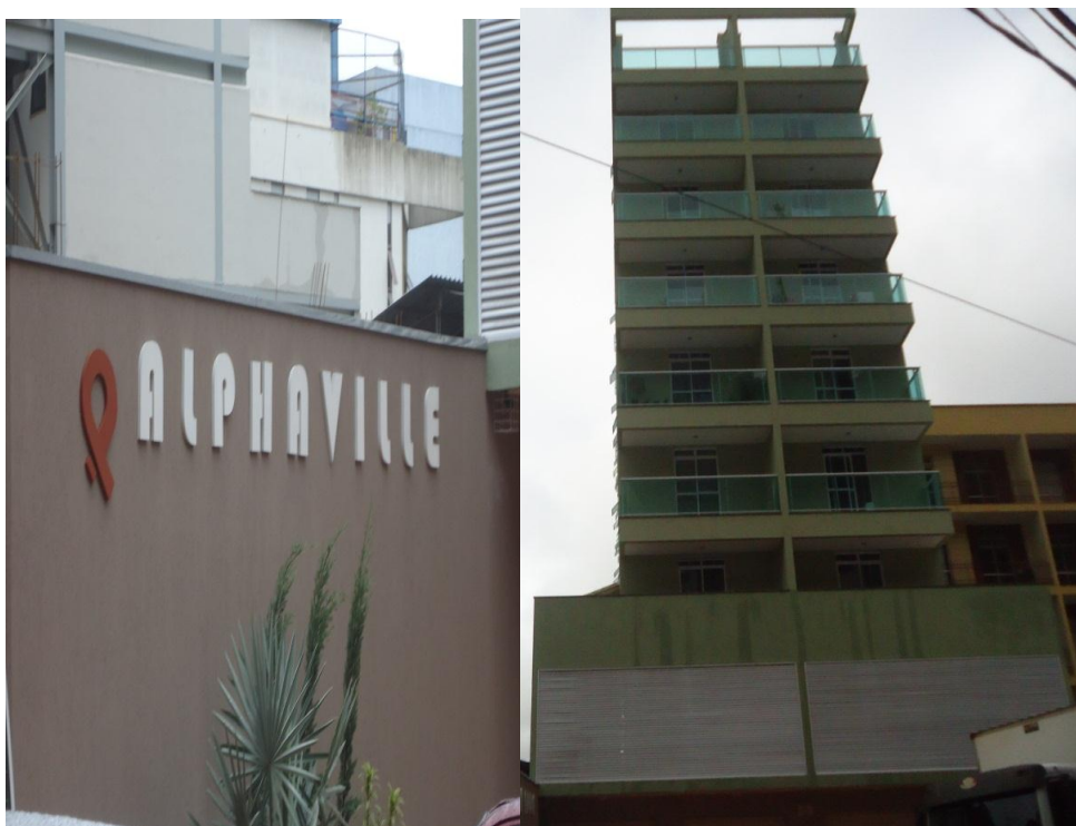
Figura 5: Fachada do condomínio Alphaville. Queiroga, 2015.
