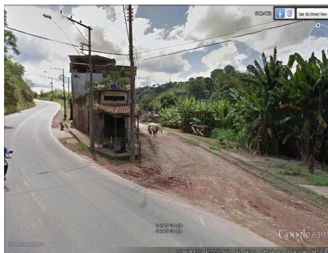
FIGURA 35: Z. P. DESCONTÍNUA DESORGANIZADA (VILA/FAVELA) – UM DOS ACESSOS AO BAIRRO SÃO JOSÉ
