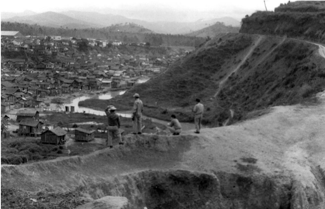
FIGURA 10: Terraplanagem do bairro Bom Jardim na década de 1960
