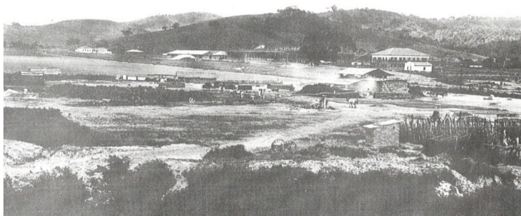
Figura 23 – Vista geral do canteiro de obras da ESAV.
