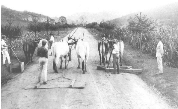
Figura 41 - Avenida da Agronomia em construção.
