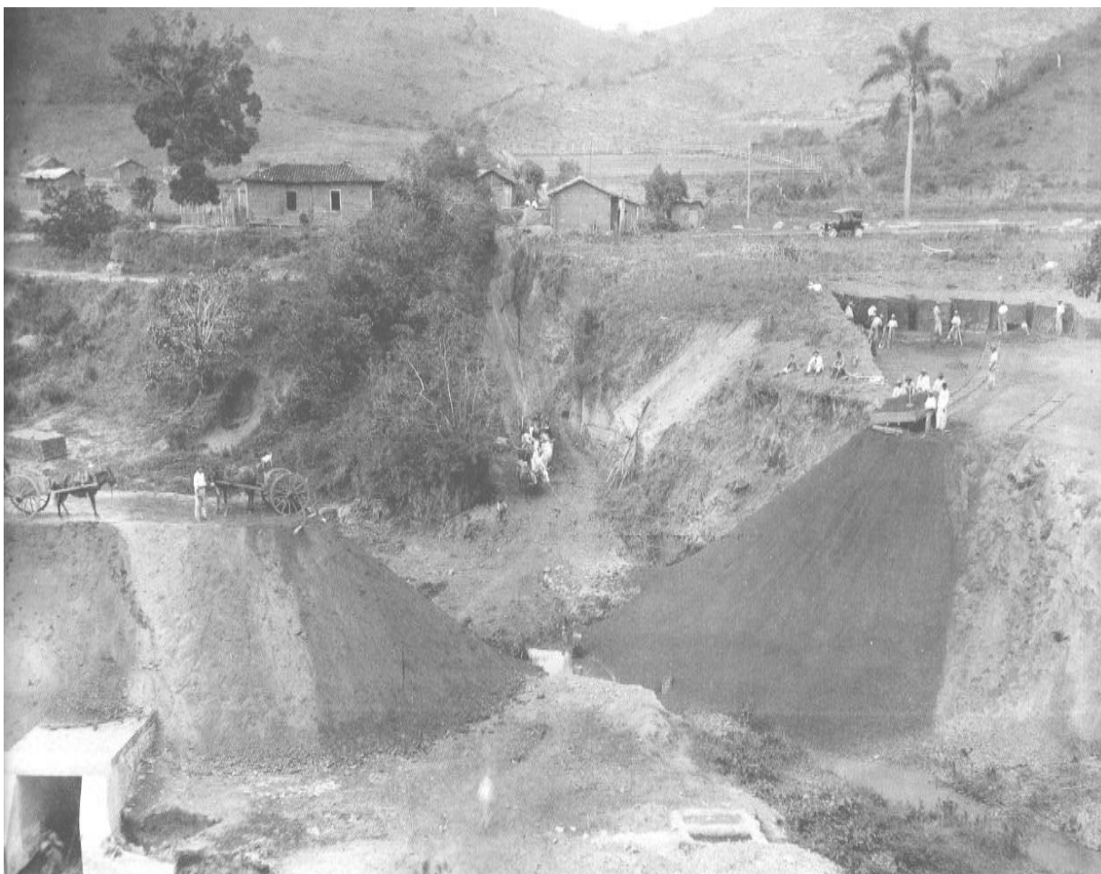
Figura 40 – Início do aterro que ligou o Campus à cidade de Viçosa, localizado próximo às quatro pilastras. Sendo demonstrado o grande grau de dificuldades na execução das obras. No detalhe, carroça puxada por muares e trole usados no aterramento da galeria.
