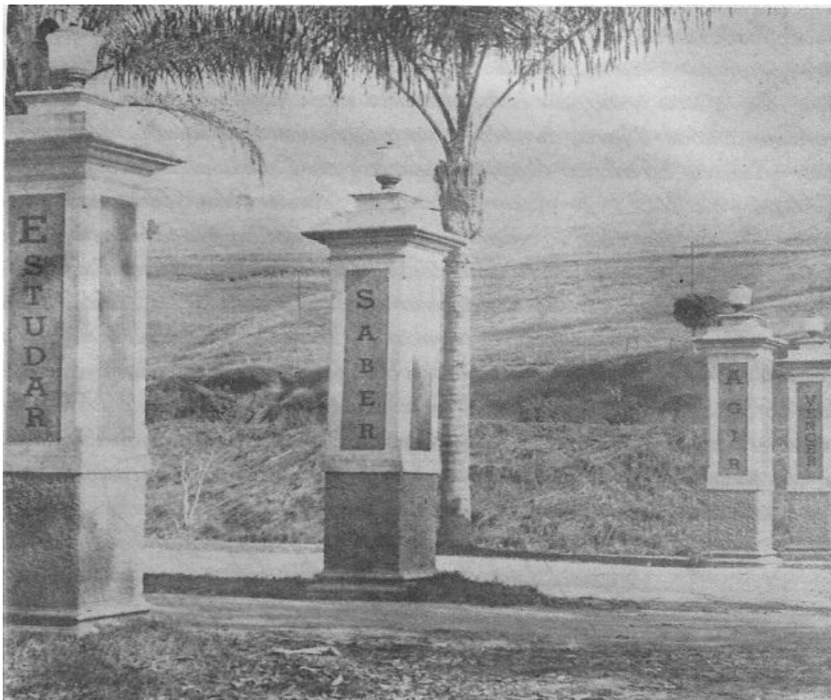
Figura 60 – As quatro pilastras originais, nota-se claramente a ausência de edificações (alojamentos), da represa e de vegetação no seu entorno.
