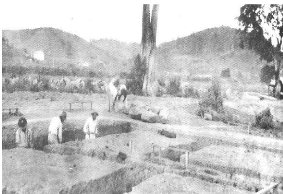
Figura 30 – Alicerces da residência do Diretor.
