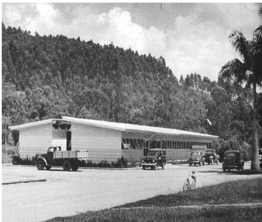
Figura 96 – Instalação da Escola Nacional de Floresta.
