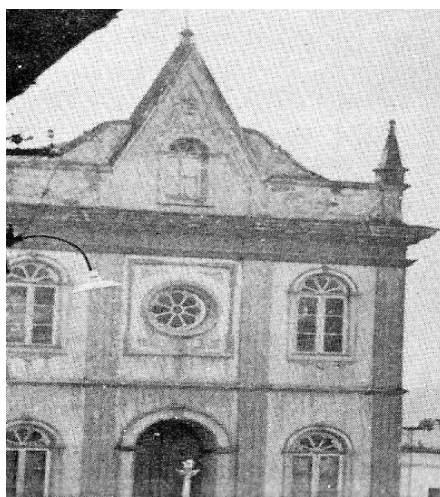
Figura 146 B – Fachada da antiga Igreja do Rosário.
