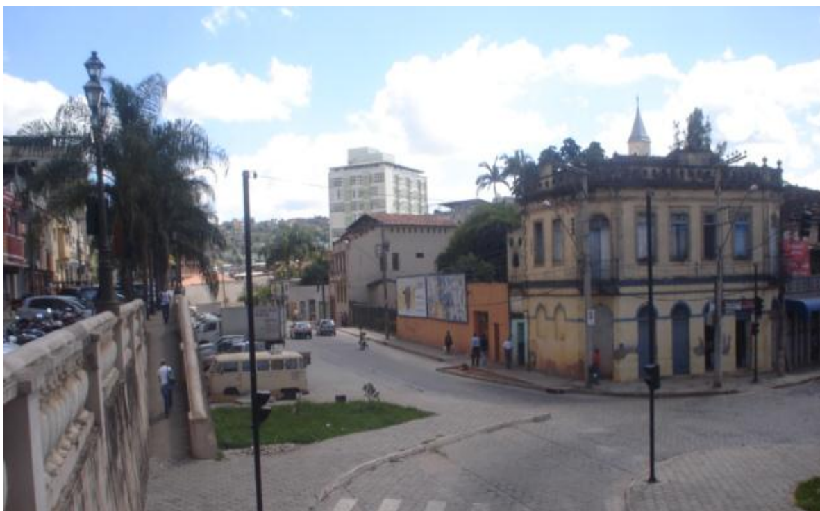
Figura 136 – Estação ferroviária com calçamento para estacionamento e semáforos em 2012.
