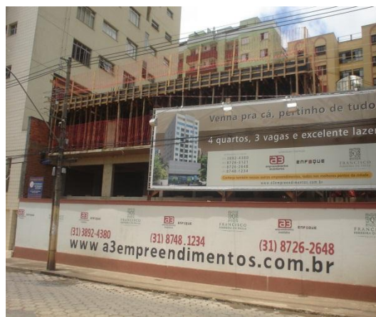
Figura 143 B – Empreendimento no local.
