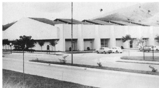
Figura 104 – Ginásio já inaugurado.
