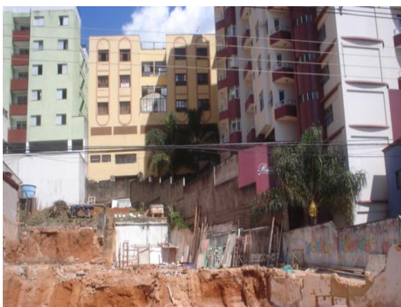
Figura 143 A – Demolição de sobrado.
