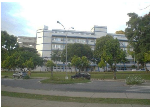
Figura 124 C: Vista parcial da UFV.
