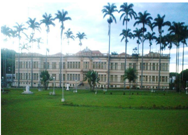
Figura 123 C: Vista parcial do Ed. Principal.
