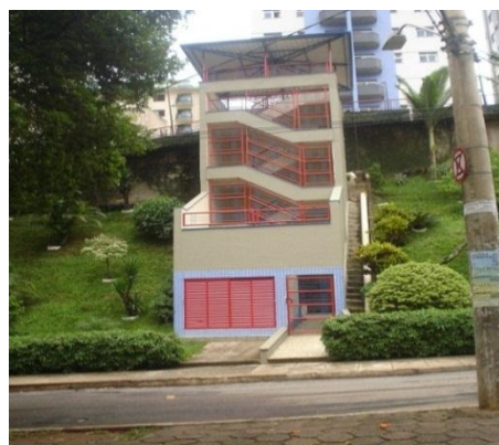
Figura 234 F – Escadaria facilitando acesso aos moradores dos edifícios.
