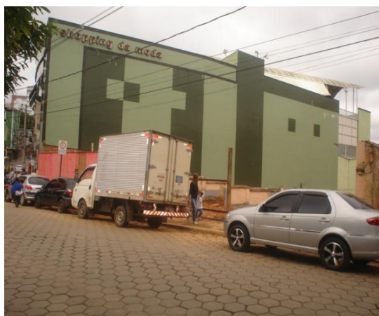
Figura 201 A – Demolição da residência.
