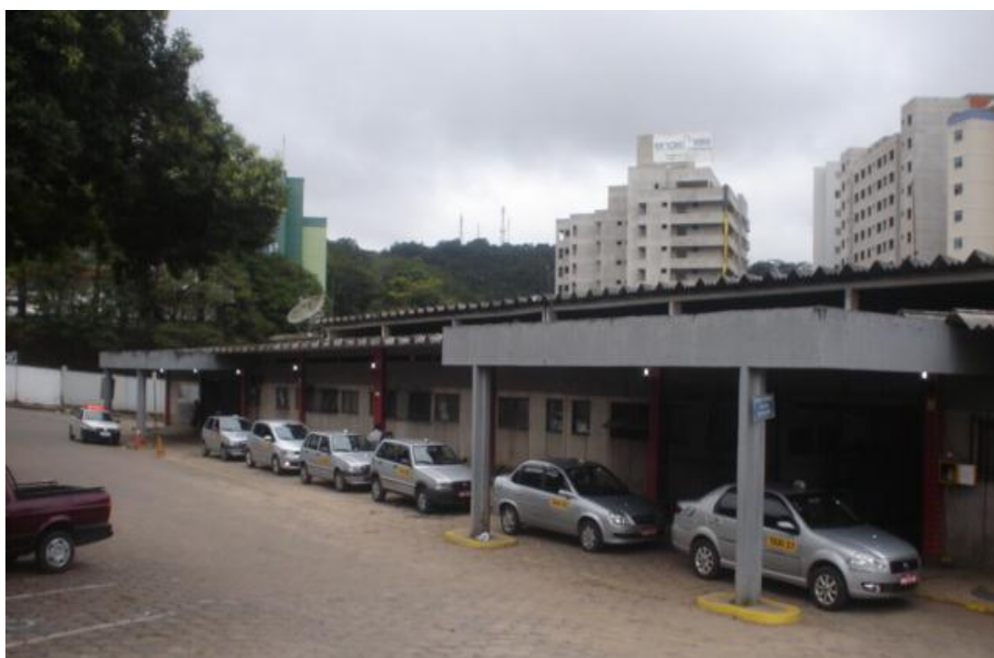
Figura 216 – Atual rodoviária localizada na Av. Marechal Castelo Branco.
