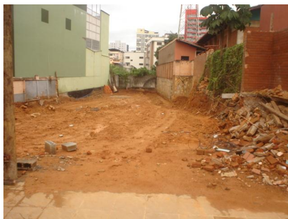
Figura 201 B – Demolição da residência.
