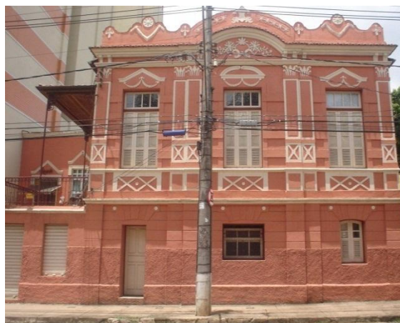
Figura 175 – A mesma residência bem preservada na Av. Bueno Brandão no ano de 2013.
