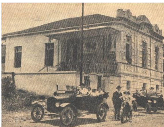
Figura 174 – Residência na Av. Bueno Brandão na década de 20.
