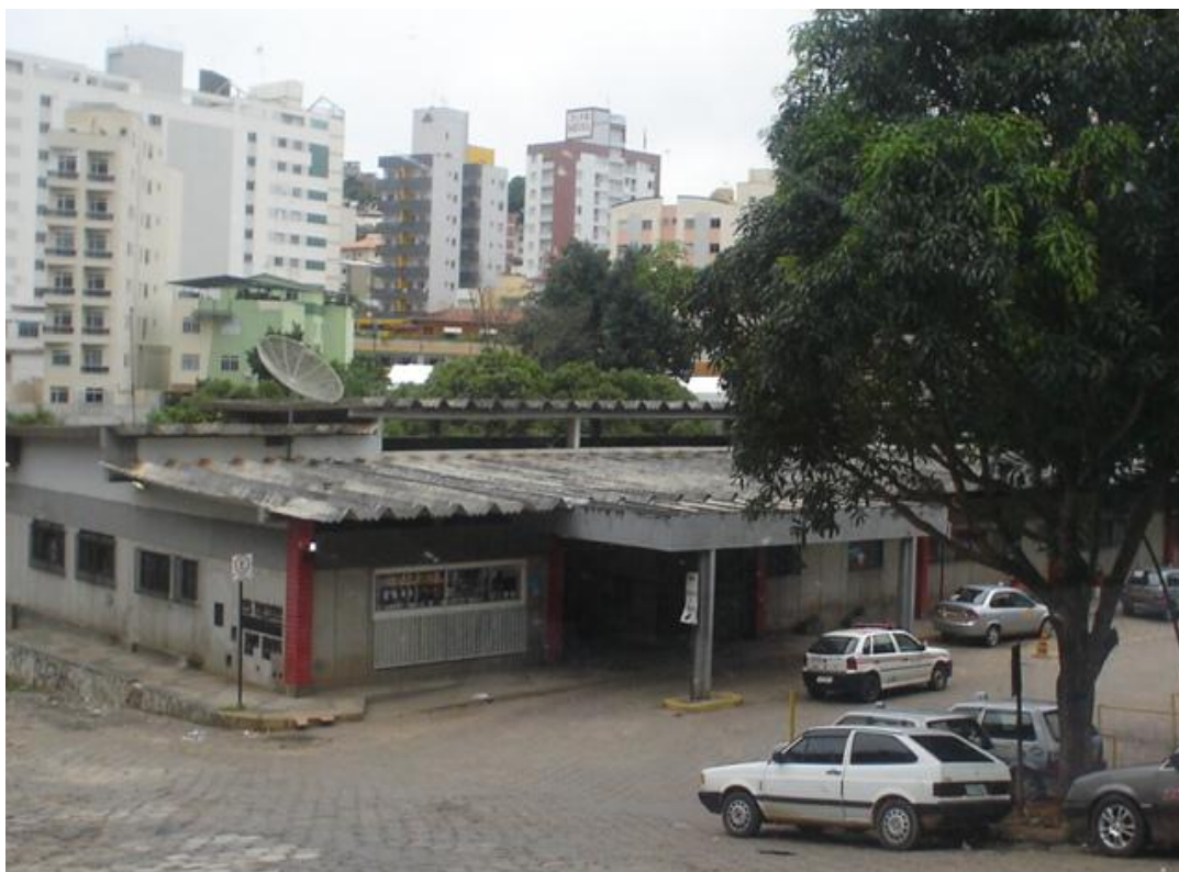
Figura 215 – Atual rodoviária localizada na Av. Marechal Castelo Branco, antes sua localização era considerada a entrada da cidade (antigo trevo).
