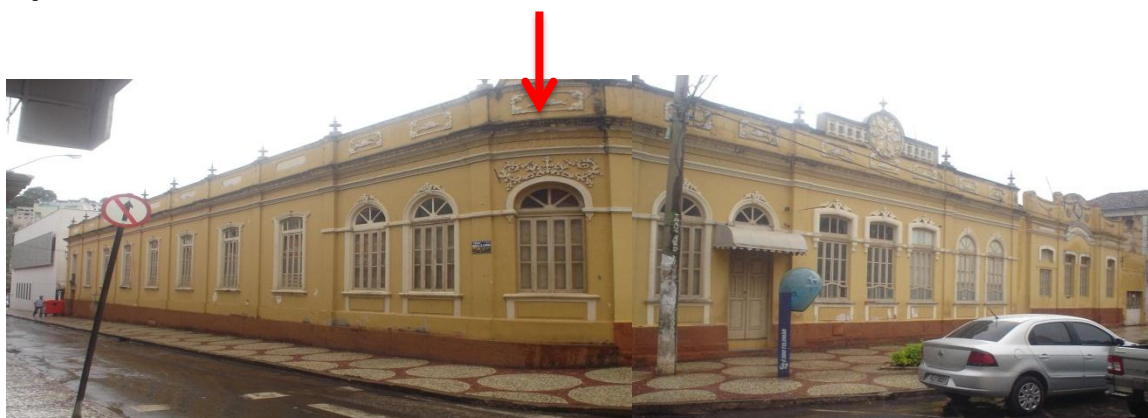
Figura 220 – Montagem da fachada do Hotel Rubim no ano de 2013, observa-se que a porta mudou de lado, antes ficava na fachada decorada debaixo do beiral (localizado na seta).
