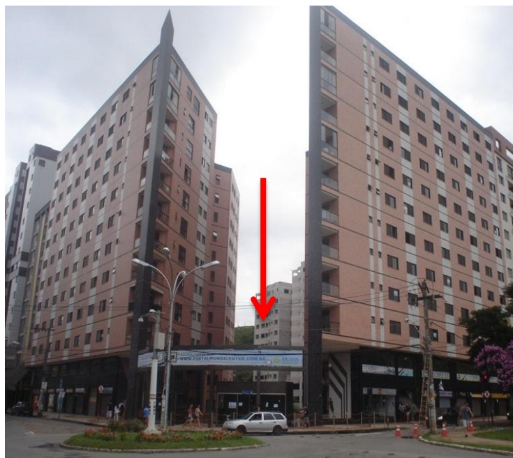
Figura 232 – Jardins suspensos (localizados abaixo da seta vermelha) sobre galeria que dá vazão para as águas das represas da UFV.
