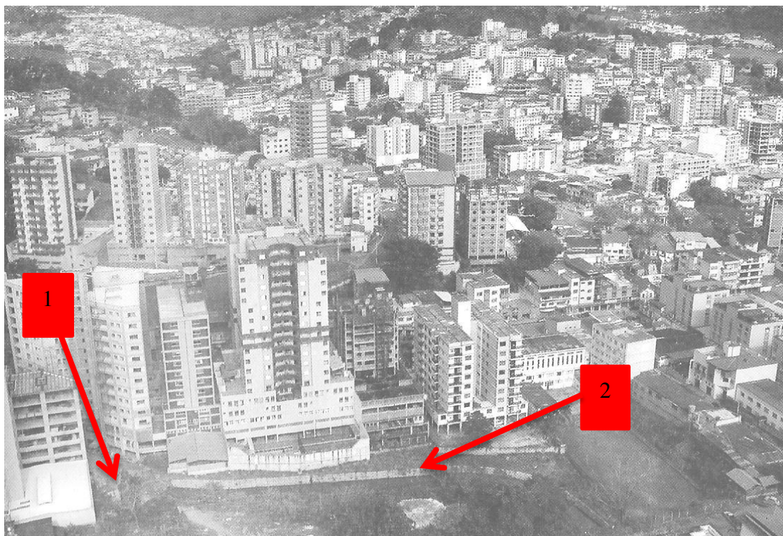
Figura 227 – Total verticalização das áreas centrais próximas ao Campus da UFV, desrespeitando a área de preservação permanente do Ribeirão São Bartolomeu na Rua dos Estudantes (APP localizada na seta vermelha de número 1 e 2). Outro exemplo é o condomínio na Av. Peter H. Rolfs que possui o seu jardim suspenso (entre suas duas torres) construído sobre a galeria (localizada na seta vermelha de número 1) que dá vazão para as represas da UFV ao Ribeirão São Bartolomeu. A galeria que fora demonstrado na figura 39.
