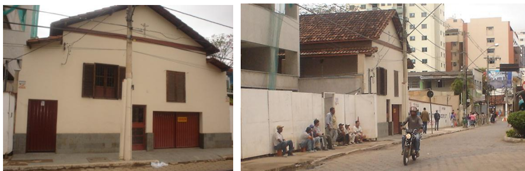
Figura 203 A – Sobrado na Praça do Rosário. Figura 203 B – Sobrado na Praça do Rosário. Figuras 203 - Antigo sobrado na Praça do Rosário ladeado por empreendimentos imobiliários. Fonte: Arquivo Pessoal. Data: 17/05/2012.
