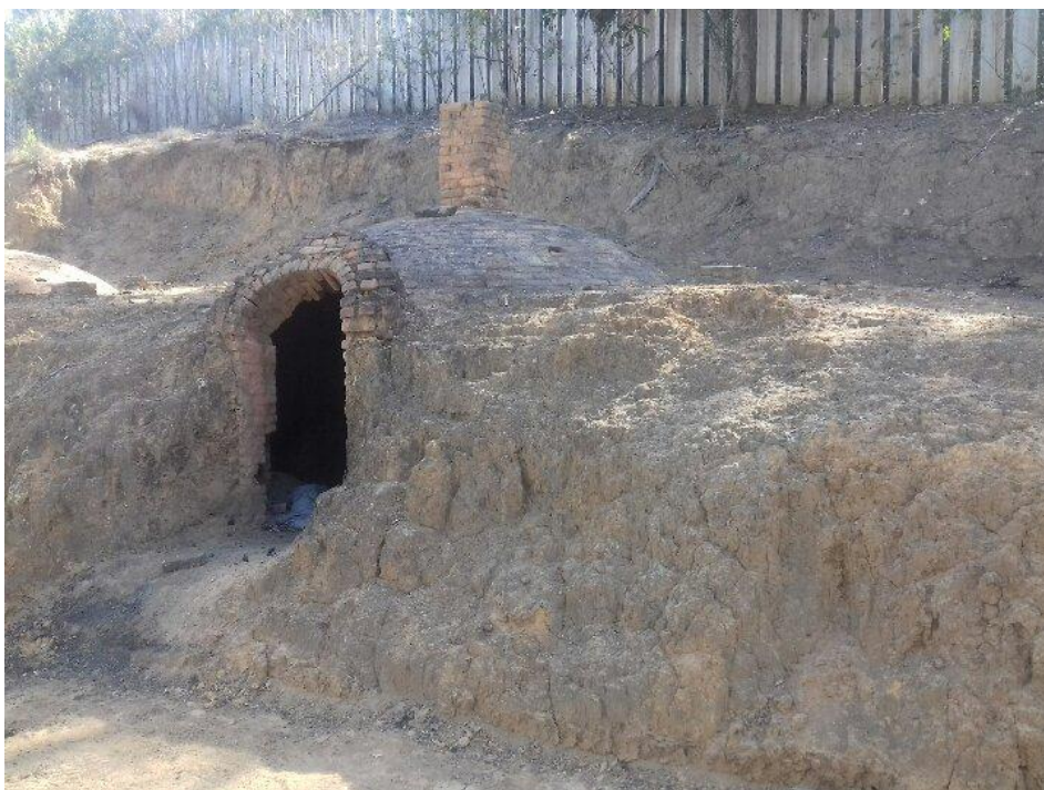
FIGURA 8 – Forno de Encosta (Foto: Autoria Própria, 2017; Laboratório de Painéis e Energia da Madeira – Viçosa/MG)
