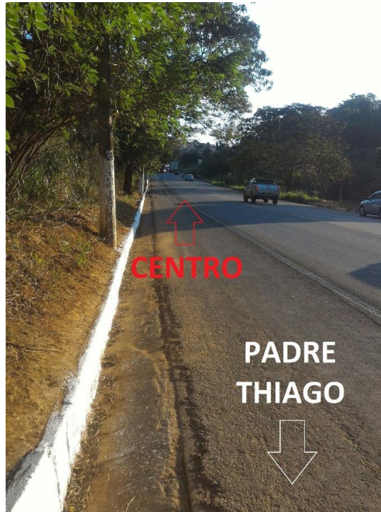
Figura 14: Ausência de aparelhamento urbano. BR-356 (2018);
