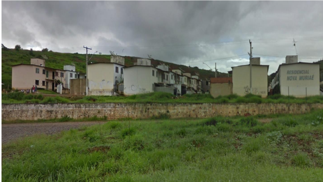
Figura 8 – Fachada do residencial “Nova Muriaé”, vista obtida do trecho da BR-356;
