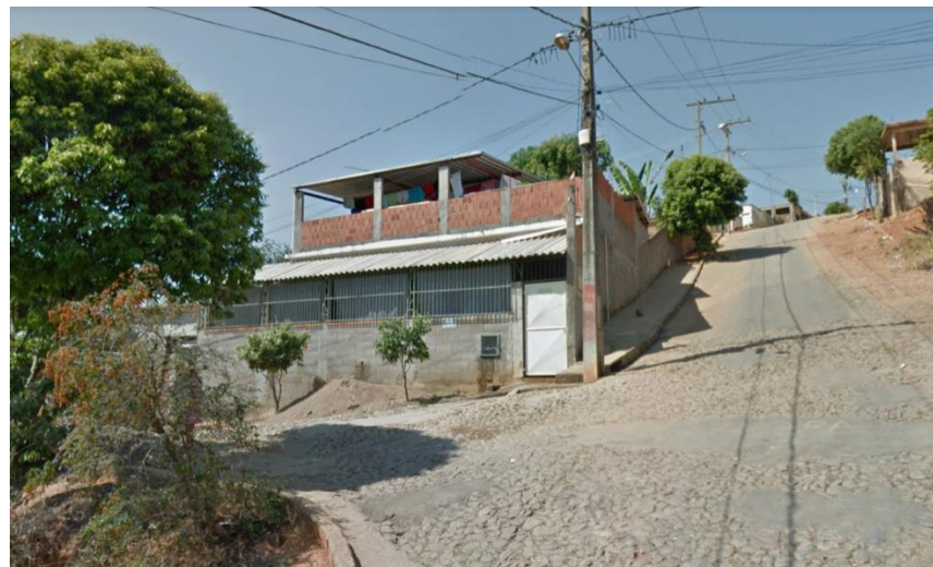
Figura 12: Residência ampliada do Pró-Moradia;
