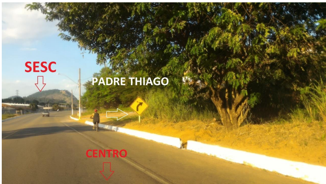
Figura 13: Ausência de aparelhamento urbano. BR-356 (2018);
