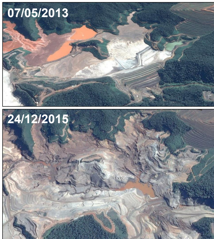
Figura 4. Efeitos locais do rompimento da barragem.
