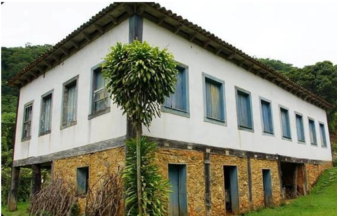
Figura 01: Construção mais antiga do município, Casarão da família Scabello. Esse modelo arquitetônico segue o padrão de construção da época. Fonte: Prefeitura Municipal. Disponível em: http://vendanova.es.gov.br/website/site/Index.aspx
