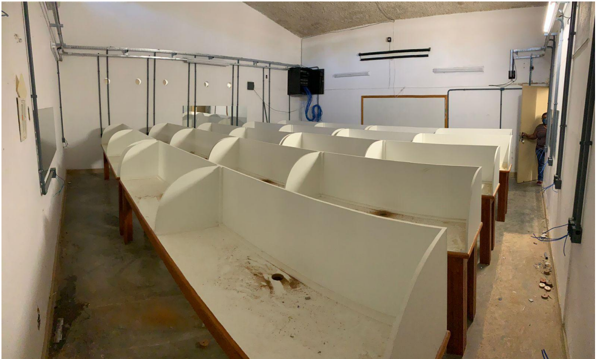
FIGURA 09 – “Sala de Informática (em reforma) – fotografia tirada no dia 15/02/2022”
