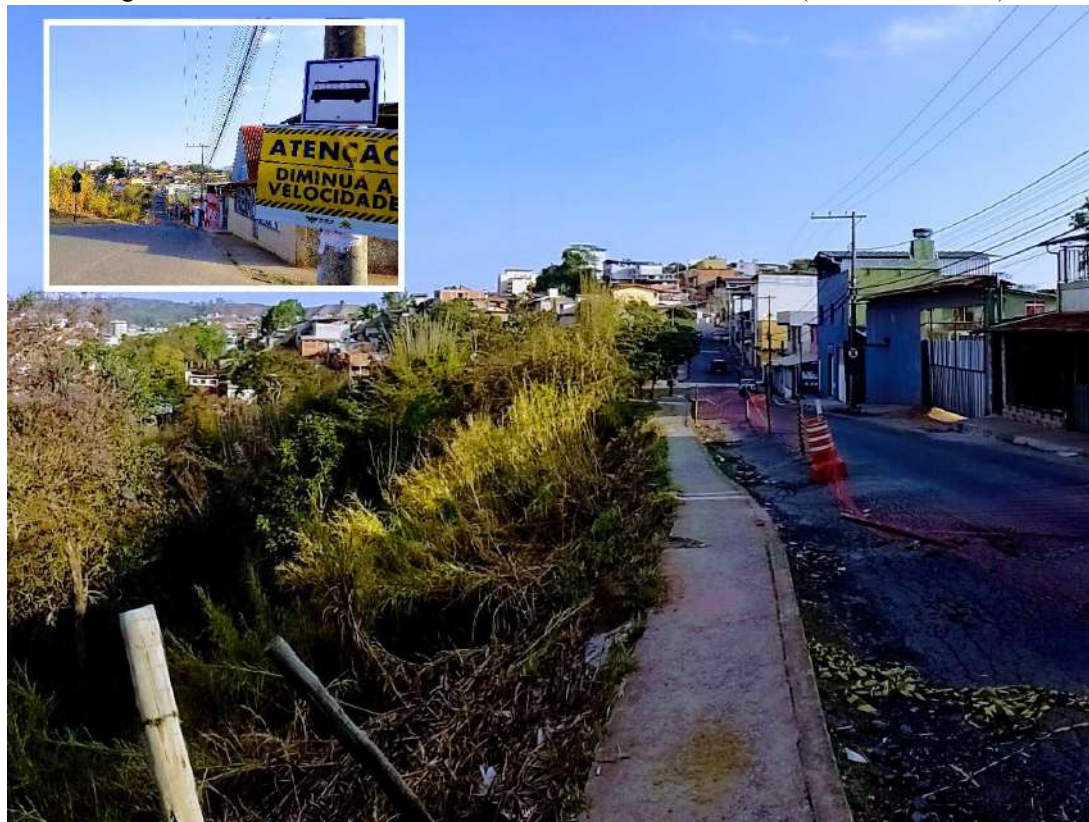
Figura 16: Rebaixamento do terreno na Av. Juscelino Kubitschek (setembro de 2022)
