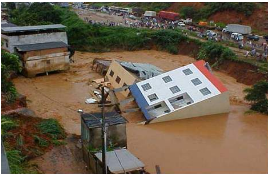
Figura 09: Prédios desmoronados em 16/01/2003.
